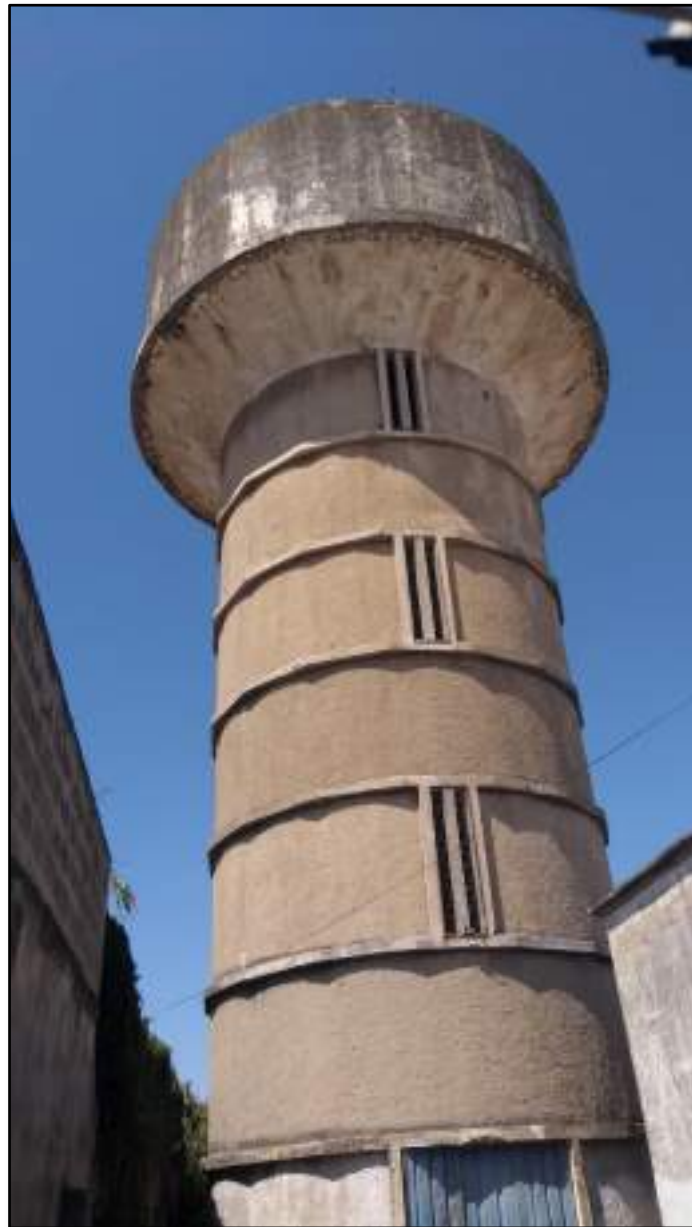
Figura 4: Tanque de agua de 500 m 3 en desuso.
