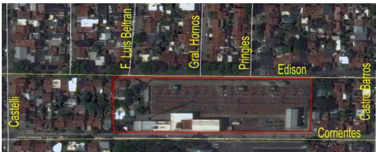
Figura 1. Lugar de emplazamiento de la ET Edison.
