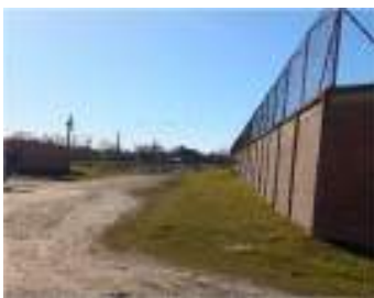
Foto 15: Calle Antártida Argentina y S.E. Paso del Rey
