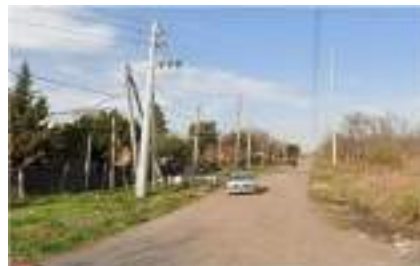
Foto 4: Fosa N°2 - Calle Gavilán y Av. Argentina
