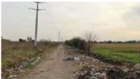
Foto 3: Fosa N°2 - Calle Gavilán y calle Anderson
