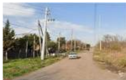
Foto 4: Fosa N°2 - Calle Gavilán y Av. Argentina
