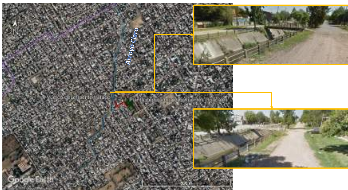
Figura 52: Arroyo Claro en las cercanías donde se propone la descarga de la planta.
