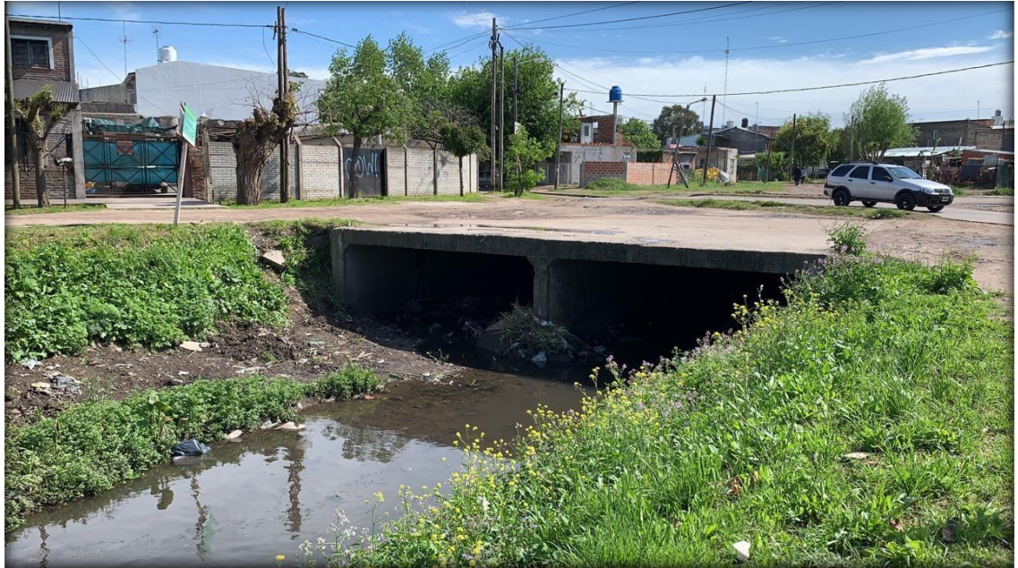
Fig. 13: Diagonal Martín García: alcantarillado cruce de puente.
