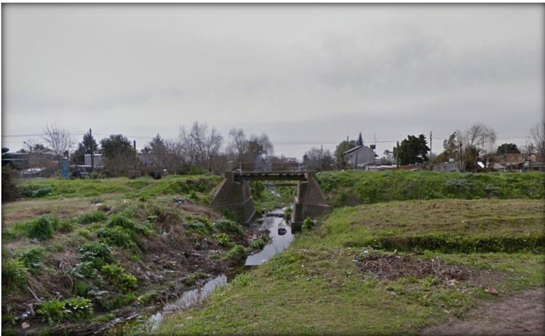
Fig. 20: Calle 210 y Granaderos de San Martín. Puente peatonal existente
