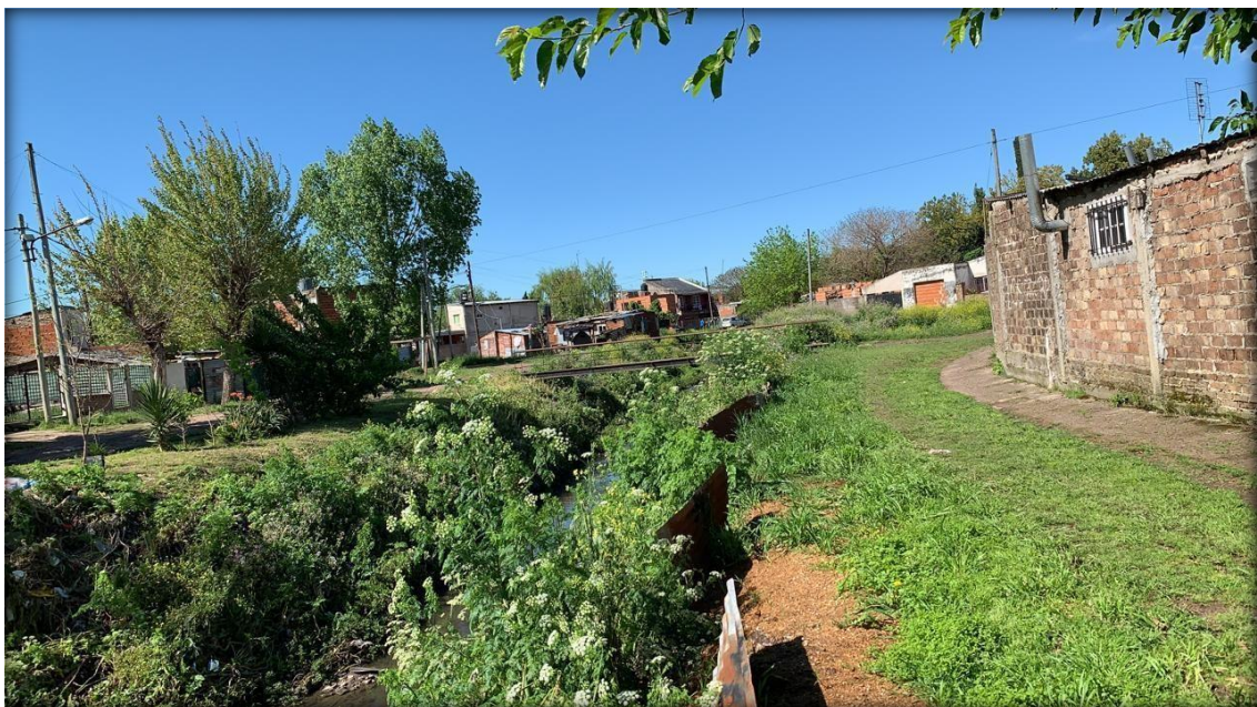
Fig. 8: Diagonal Martín García y Pilar, altura puente peatonal.
