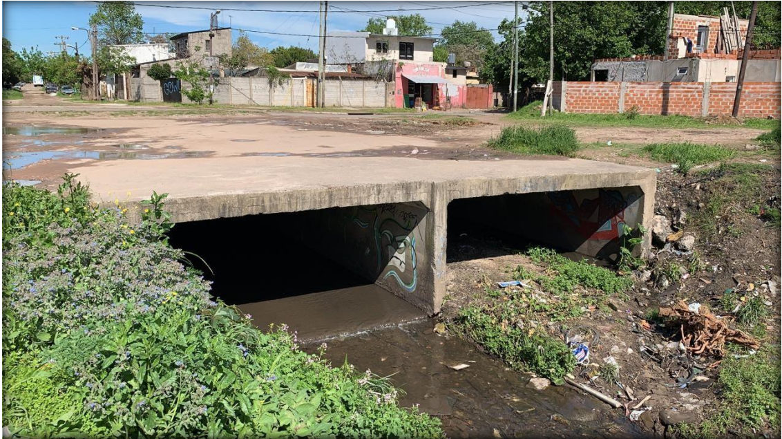
Fig. 11: Diagonal Martín García: alcantarillado cruce de puente.
