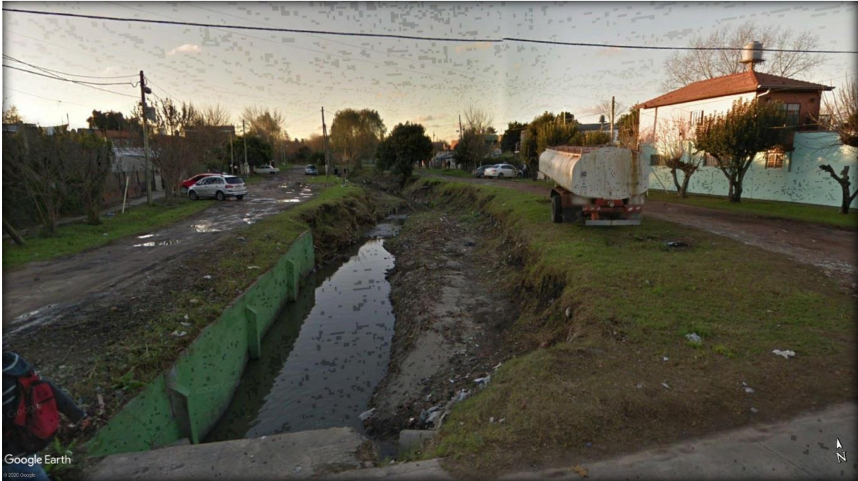
Fig. 17: Contreras y Parrillo. Empalme con conducto existente (aguas arriba)
