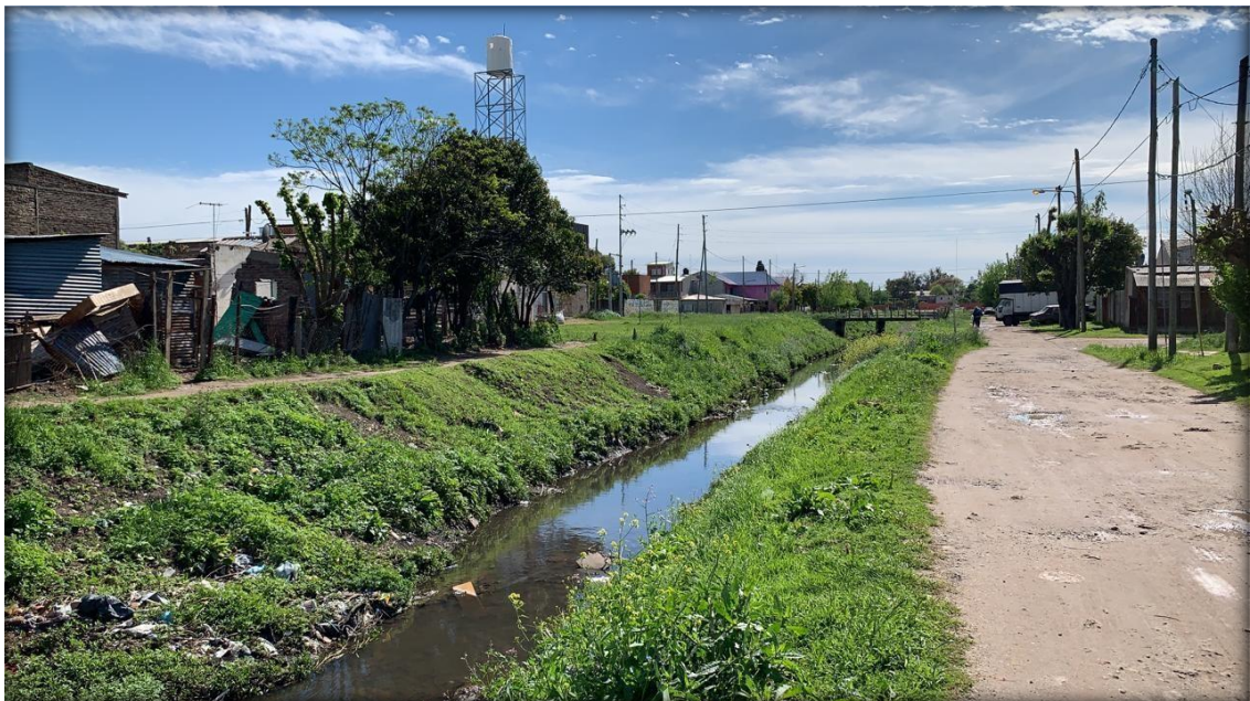
Fig. 12: Diagonal Martín García y Pilar: vista puente peatonal en calle Pilar.
