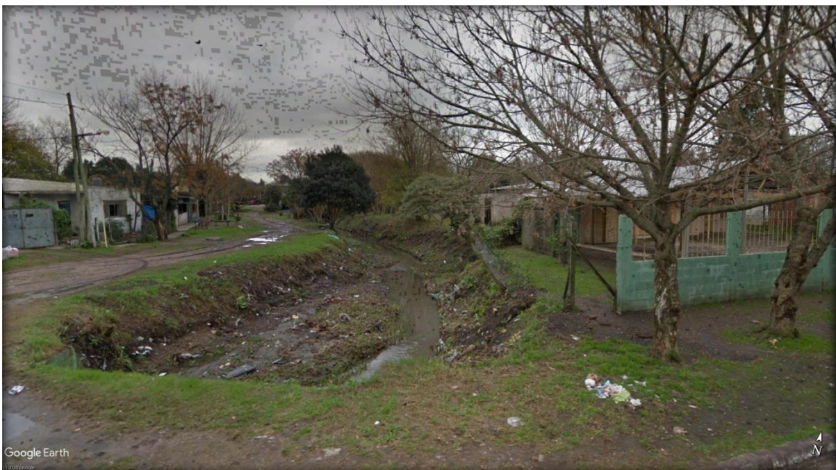
Fig. 18: Alem y Parrillo. Puente.
