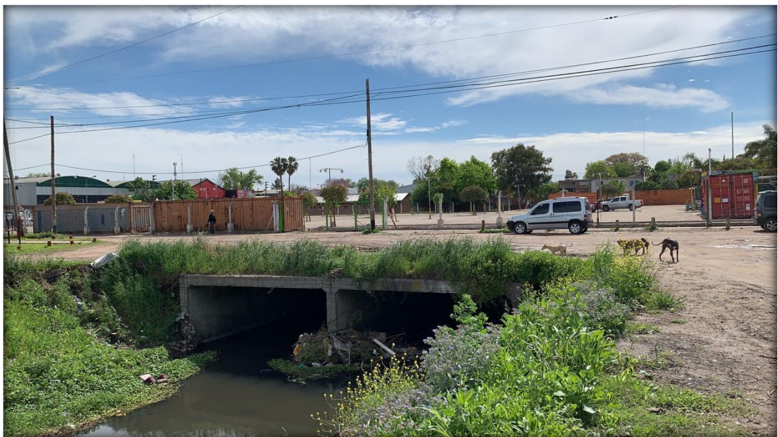
Fig. 16: Necochea y Esposos Curie. Punto de empalme con entubado existente. Vista aguas abajo.
