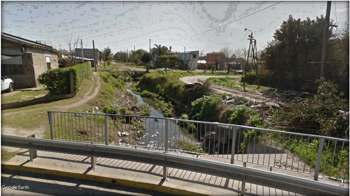
Fig. 19: Calle Thevenet y Parrillo. Puente vehicular y peatonal.
