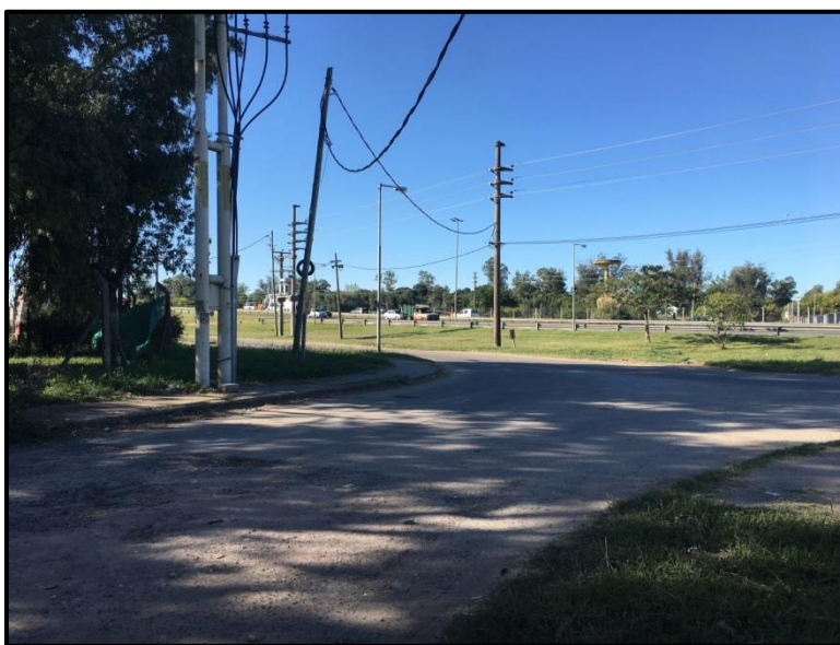
Imagen N° 2.12: Cruce de Ing. Allan y colectora. A partir de este punto el gasoducto corre de forma paralela a la ruta provincial N° 2, hasta el ingreso del mismo a Base Gutiérrez. Coordenadas geográficas: 34°51'57,78" S y 58°10'47,75" W.
