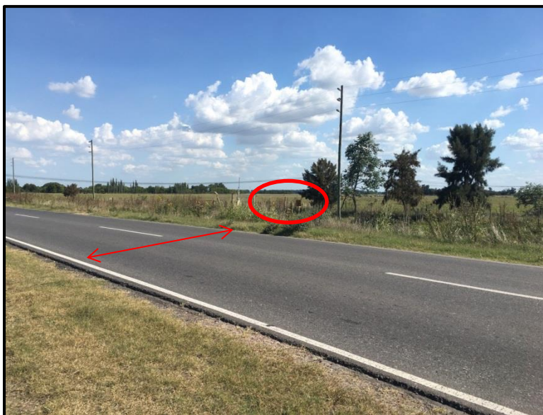
Imagen N° 2.5: Cruce del gasoducto con la Ruta Provincial N° 53. La misma deberá ser intervenida para la realización de la obra. Coordenadas geográficas: 34°58'24,90" S y 58°15'02,39" W.
