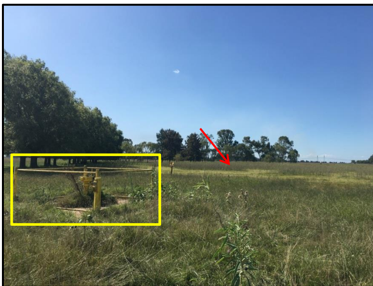
Imagen N° 2.3: Arroyo y laguna por la que cruza el gasoducto (marcada con una flecha roja) y la válvula (en amarillo). Si bien al momento del relevamiento la zona se encontraba
