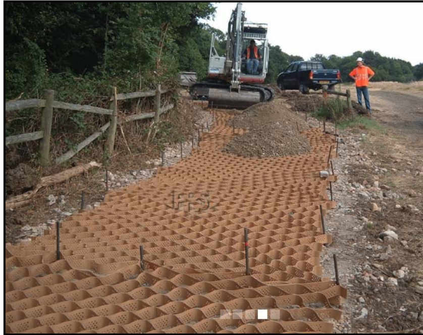
Fotografía 13: colocación de Geoceldas – Rellenos
