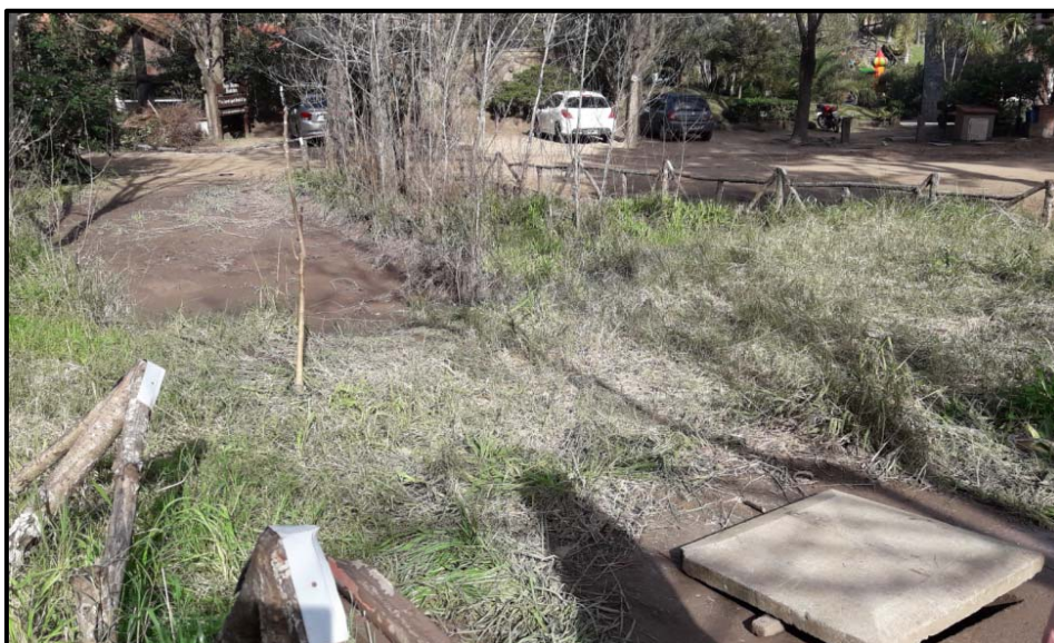
Fotografía 2: Cámara en Calandria y Avellano con bombeo hacia dren.
