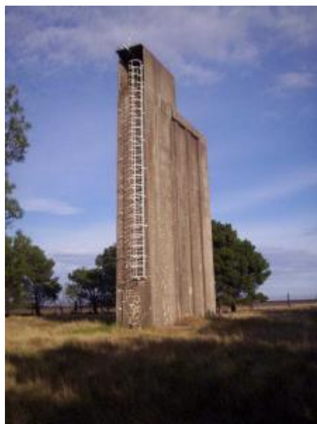
Figura 8: Acueducto Principal – Hormigón Pretensado
