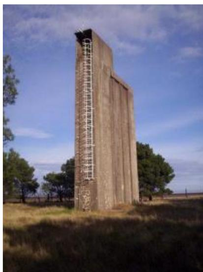
**Figura 5: Acueducto Principal – Hormigón Pretensado**
