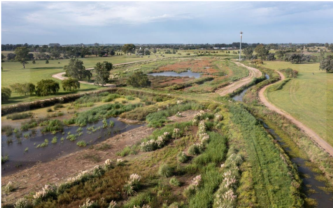
Figura 12. Vista de la laguna artificial (cuenco) en el que descarga la red pluvial proyectada. Fuente: DPH
