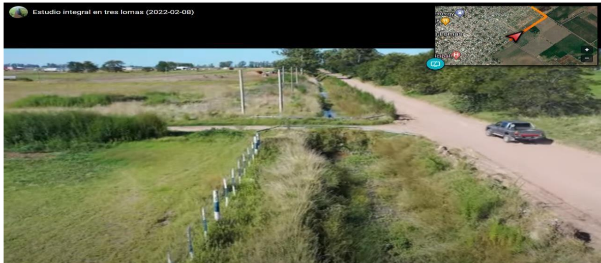
Figura 4b. Vista del canal existente en calle Echeverría (entre Belgrano y Alte. Brown). Fuente: DPH
