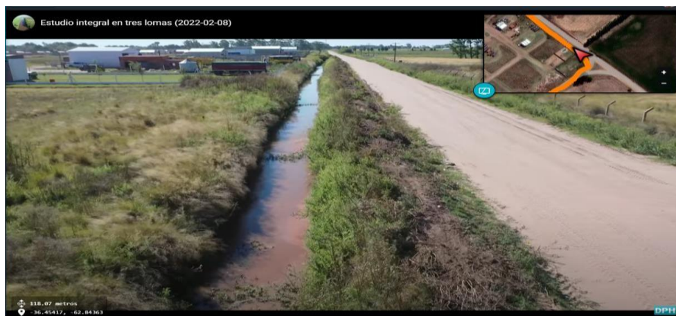
Figura 4c. Vista del canal existente en calle J Newbery (entre E. Echeverría y C. Larralde). Fuente: DPH.
