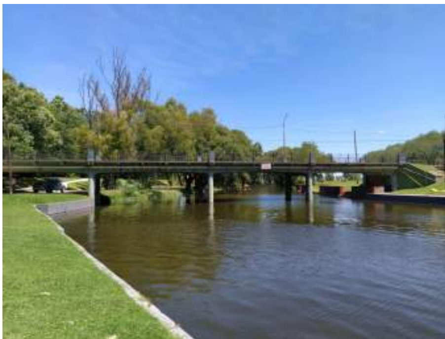
Imagen 4: Puente de la calle 9 de Julio.
