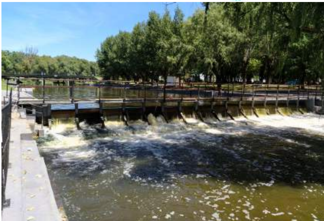
Imagen 6: Compuertas del Balneario Municipal.
