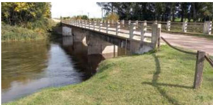
Imagen 3: Puente de la calle Santiago F. Salvo.
