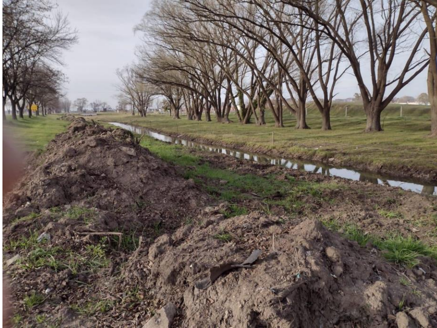
Figura 21. Desagüe existente paralelo a la RP N°86. Fuente: Municipalidad de General La Madrid
