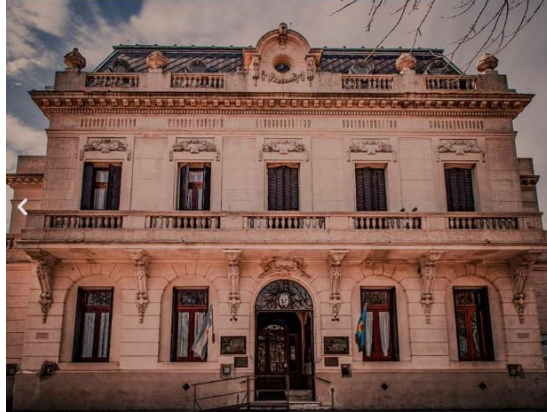
Figura 34. Edificio Municipal. Fuente: Municipalidad de Gral La Madrid, https://www.lamadrid.gob.ar/
