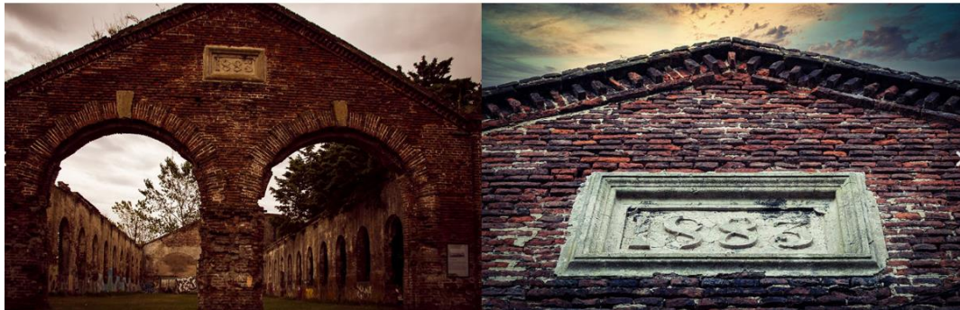
Figura 30. Galpón de máquinas FFCC. Fuente: Municipalidad de Gral La Madrid, https://www.lamadrid.gob.ar/
