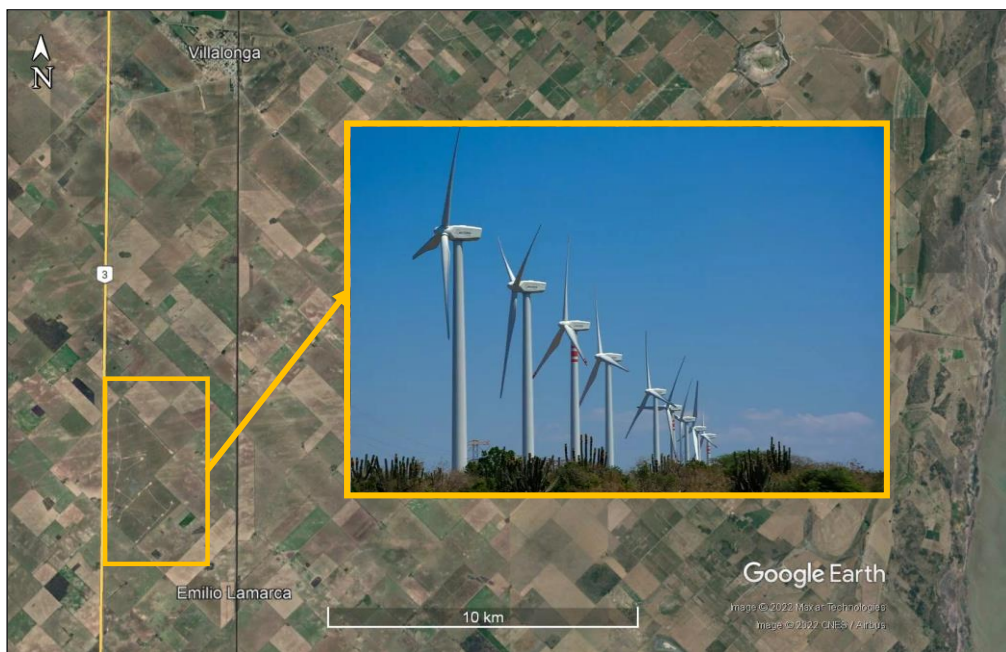
Figura 42: Ubicación del parque Eólico Villalonga.
