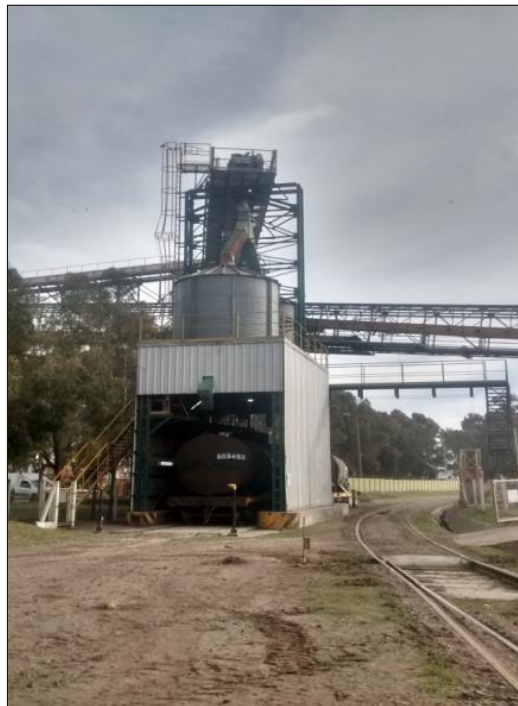
Imagen 38. Sector de carga de aceites y otros subproductos.
