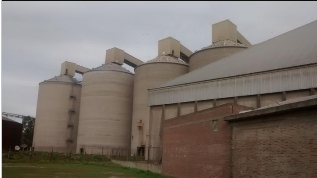
Imagen 31: Silos de almacenamiento
