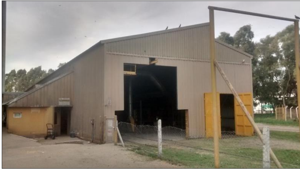
Imagen 27: Área de descarga de vagones.
