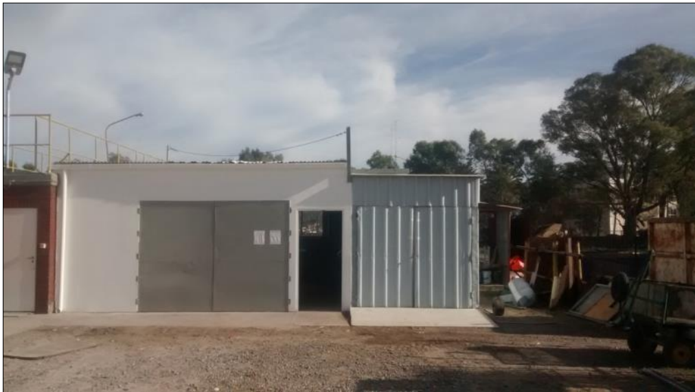
Imagen 40. Taller de mantenimiento mecánico.
