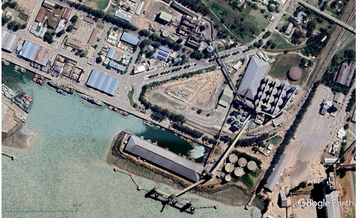
Imagen 1. Ubicación de la planta y sus entornos Fuente: Google Earth
