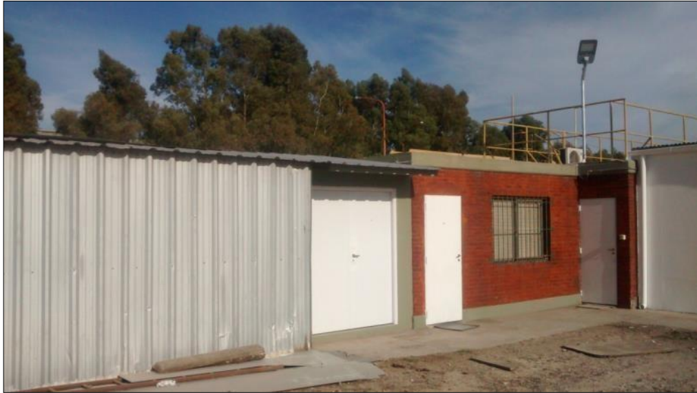
Imagen 39. Taller de mantenimiento eléctrico.
