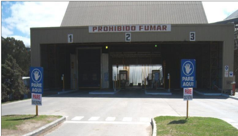
Imagen 24: Líneas de descarga de camiones
