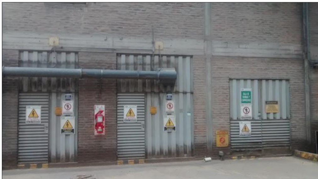
Imagen 36. Sala de motores
