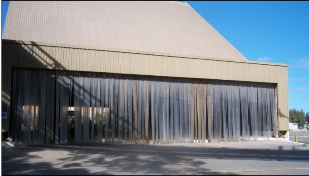
Imagen 23: Área de Descarga de camiones.
