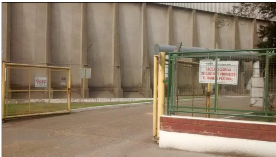
Imagen 34. Portón de egreso de camiones y vehículos.
