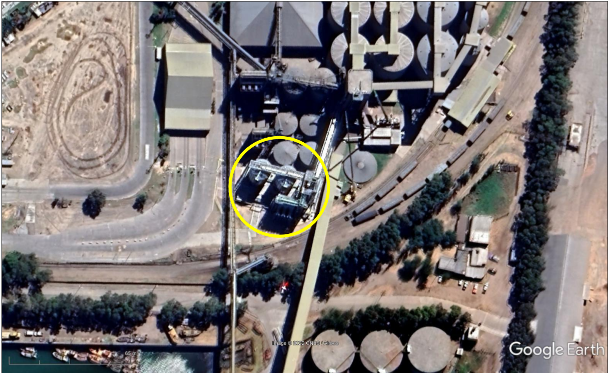
Imagen 42: Secadora de granos y silos correspondientes Fuente: Google Earth
