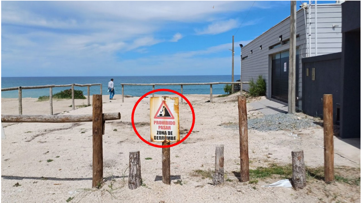
Figura 111. Viviendas sobre el acantilado con riesgo de derrumbe. Bahía de los Vientos, punto N1. Fuente: MAPBA
