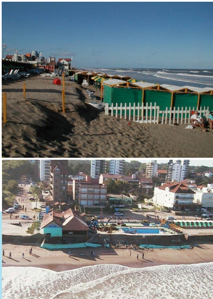
Figura 32. Instalación inadecuada de balneario (arriba). Destrucción de construcción balnearia (abajo) Fuente: Isla y Garzo, 2024
