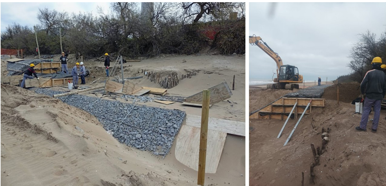
Figura 48. Gavión utilizado como núcleo rígido de la duna. Fuente: Imágenes aportadas por personal técnico de la obra (septiembre 2025)
