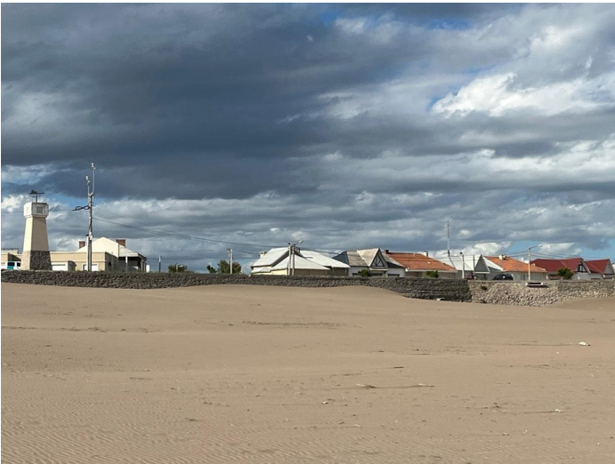
Figura 119. Defensa costera rígida en el punto TA3, donde se puede también apreciar la descarga del pluvial a la playa. Fuente: MAPBA
