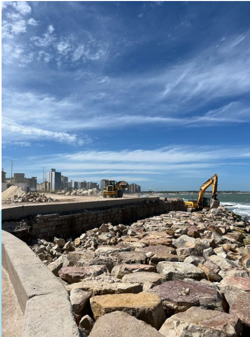
Figura 99. Colocación de enrocados en Punta Hermengo, Miramar. Punto GA12. Fuente: MAPBA
