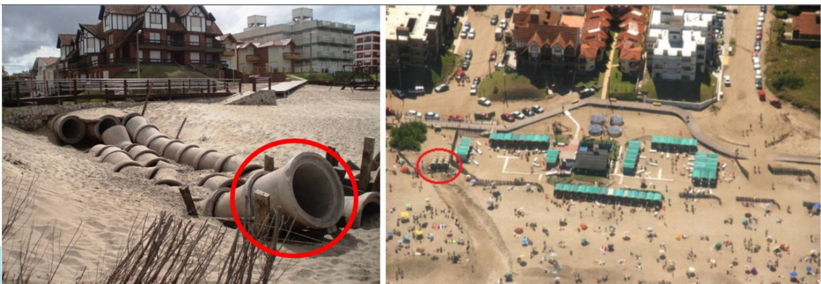
Figura 84. Villa Gesell. Desagüe pluvial en un sector de playa. Fuente: Isla y Garzo, 2024
