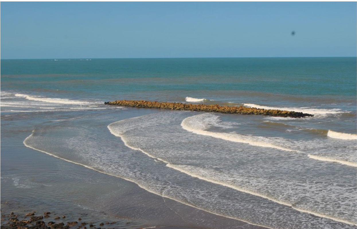
Figura 44. Rompeolas, parte del sistema de defensa en Barrio Acantilados, Gral. Pueyrredón. Fuente: MAPBA
