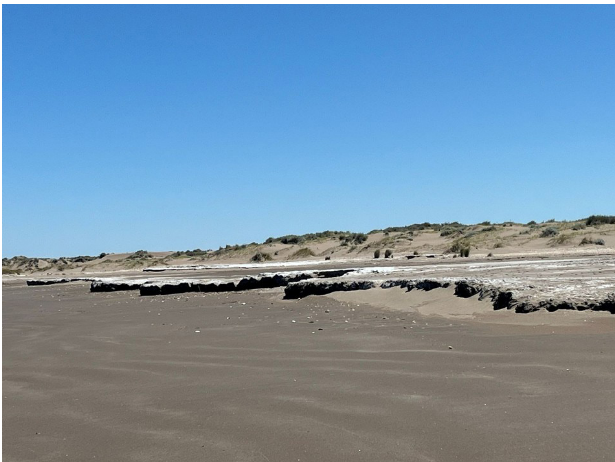
Figura 123. Escarpas erosivas en el punto MH2, Monte Hermoso. Fuente: MAPBA
