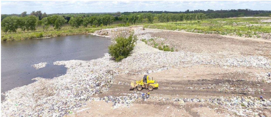
Foto 4. Vista del basural actual y disposición de residuos en la laguna artificial y el avance de la basura sobre la parcela 1042 M.
