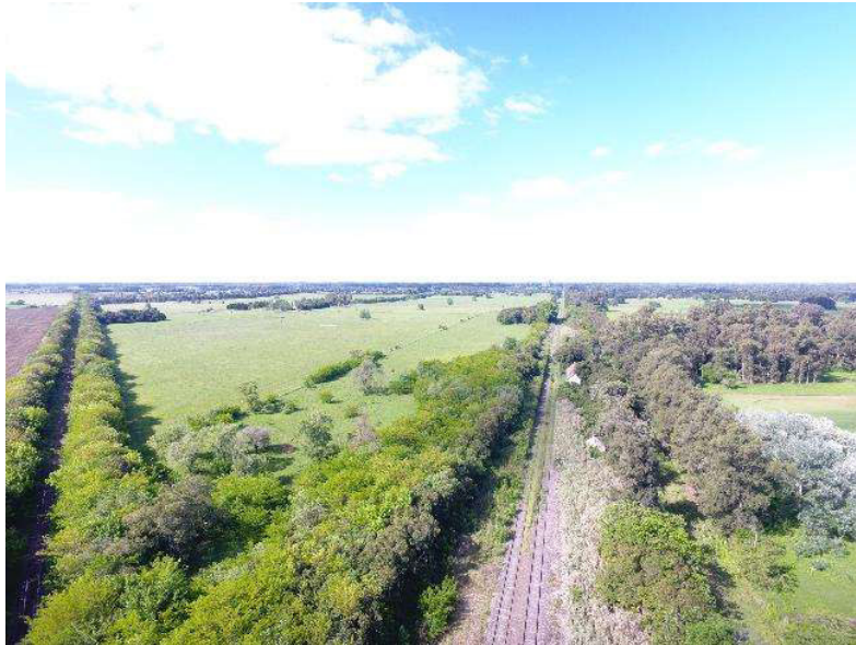
Foto 11. Vista aérea del predio de Sucre desde la intersección de las vías del FFCC Sarmiento y el camino rural de acceso.
