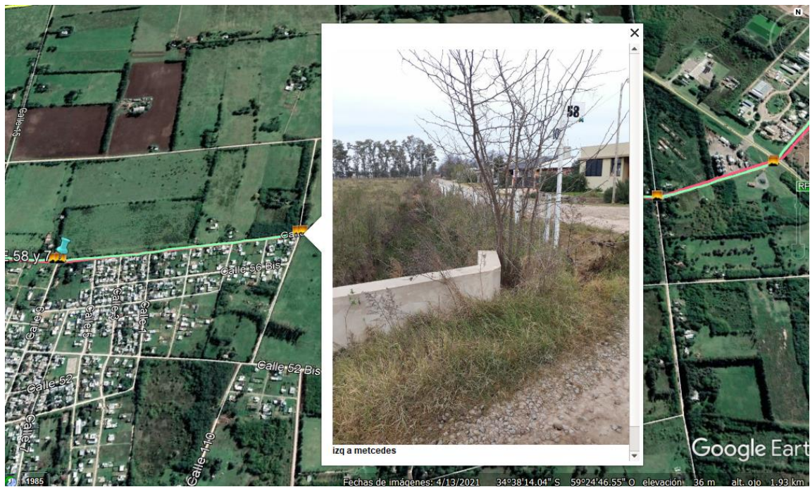
Figura 10- Calle 58 y 110 alcantarilla zanjón, inicio de urbanización.
