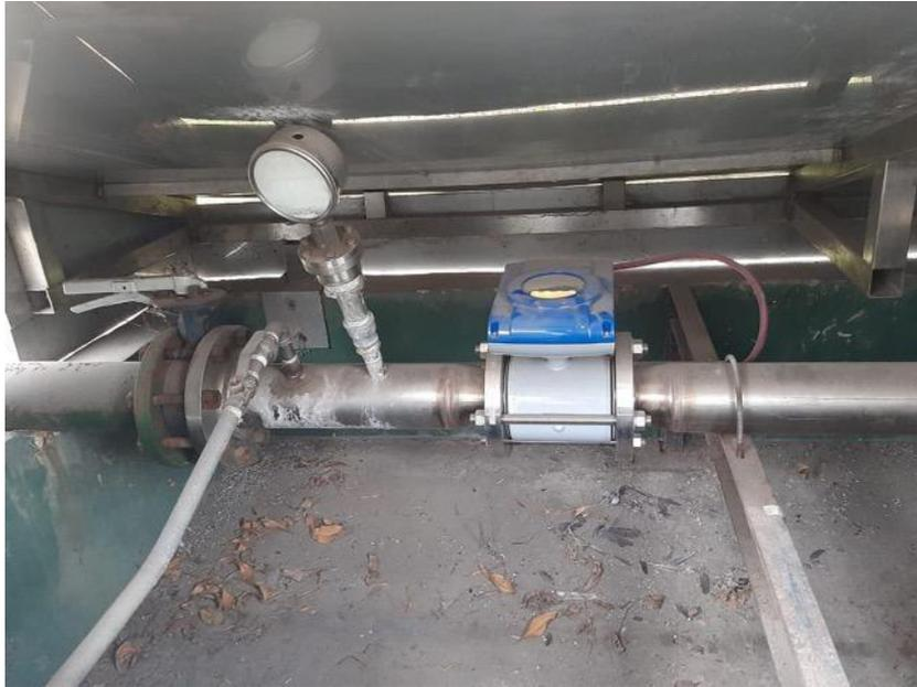
**Imagen 22:** Caudalímetro del Pozo N° 1.
