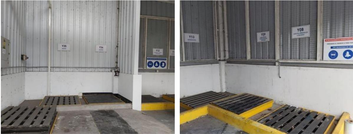
**Imágenes 19 y 20:** Interior del Depósito de residuos especiales. Contenciones anti derrames adecuadas.
