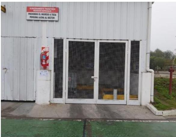
**Imagen 17:** Acceso al Depósito de residuos especiales. Ventilación, cartelería y acceso restringido adecuados.
