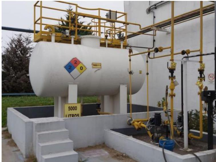
**Imagen 6:** Tanque Aéreo de Almacenamiento de Hidrocarburos TAAH.
