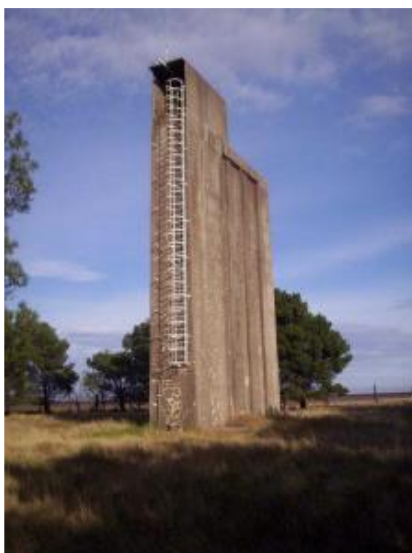
Figura 5: Acueducto Principal – Hormigón Pretensado
