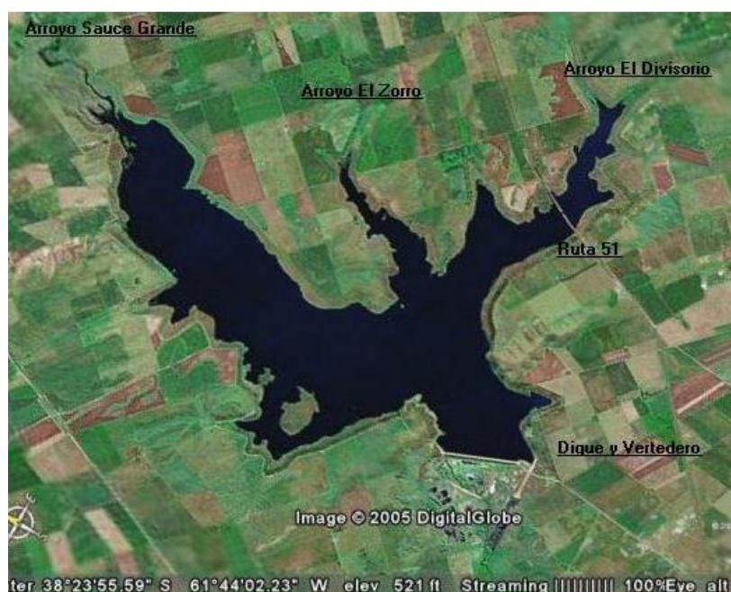
Figura 2: Imagen Satelital – Dique Paso de las Piedras
