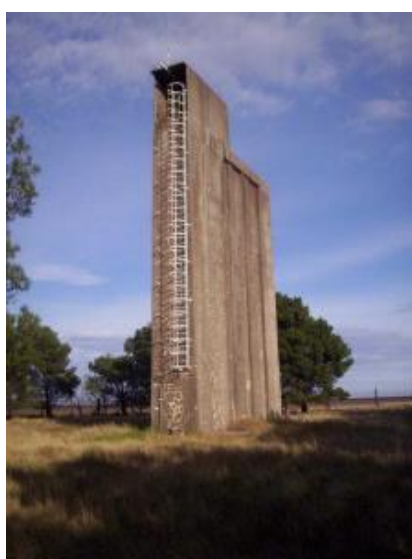
Figura 5: Acueducto Principal – Hormigón Pretensado
