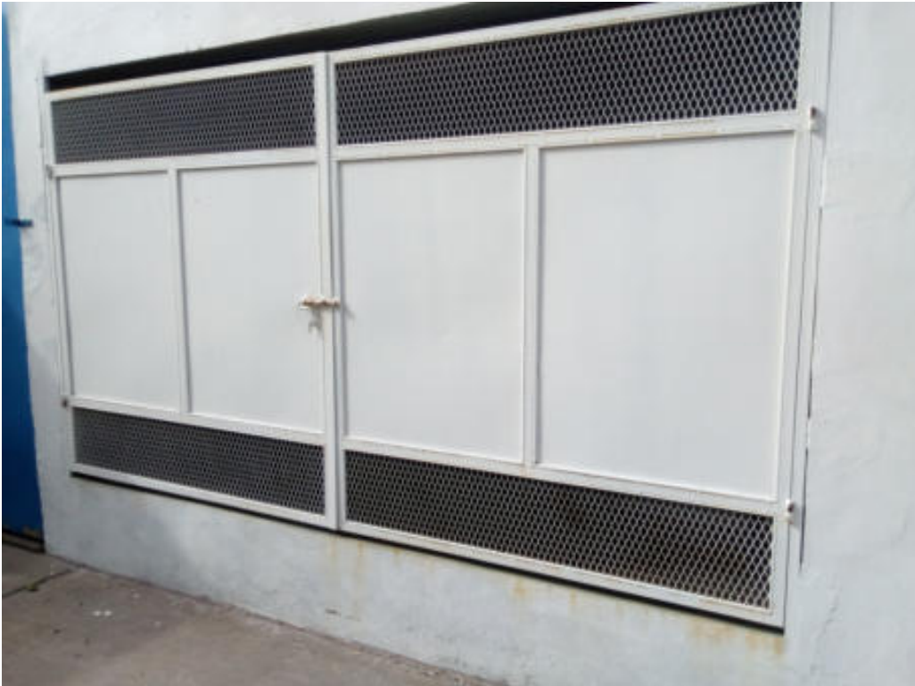
DEPOSITO DE RESIDUOS ESPECIALES (marcados en el Plano en naranja)
