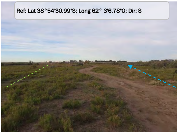
Foto 3.6-7. En la progresiva km 623,500 se observa la interferencia transversal de un acueducto (línea verde)
