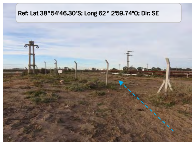
Foto 3.6-10. Ingreso de la traza al predio de OILTANKING, se observa el alambrado con mal mantenimiento.
