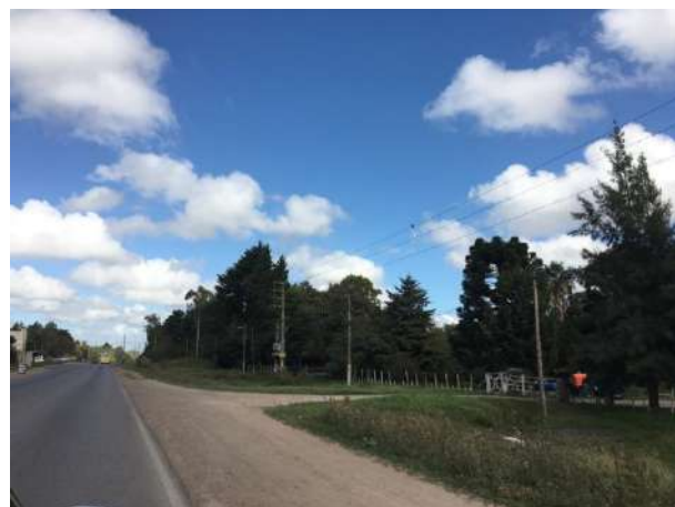
Foto 2.13. Calle 1348 se observa zona periurbana con presencia de arboleda de Casuarinas sp a la derecha del tramo. Además se verifica la presencia de luminaria municipal, gasoducto y LAT 132 kV.
