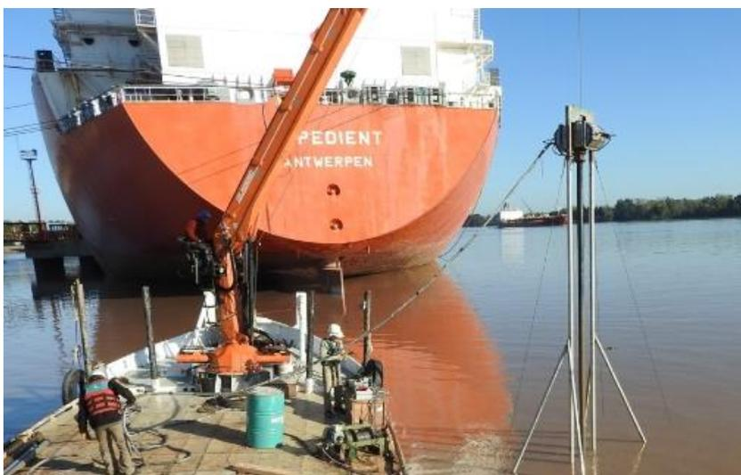
**Figura 56. Descenso del Vibrocorer FISALIA en el punto S4, a popa del buque regasificador.**
