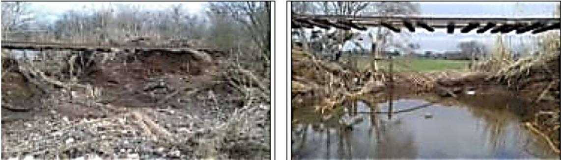
Daños ocasionados por inundación – Efecto de desmoronamiento de soporte de vías, acumulación por arrastre de piedras y escombros, deterioro de basamentos. Fuente: página web del Municipio<sup>1</sup>
