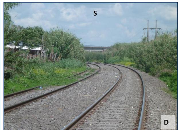
**Fotografía 16.44** Paso a nivel calle Larrea. En el sector noroeste del mismo se observa un basurero (fotos A y B). En este PAN se llevarán a cabo obras para la vinculación del FCGU y del FCBM (Ferrocarril Bartolomé Mitre). Se hará un retrochado a vía simple trocha mixta. Las imágenes C y D se corresponden con la vía doble trocha ancha del Ferrocarril Bartolomé Mitre tomados desde el PAN Larrea hacia el sur.
