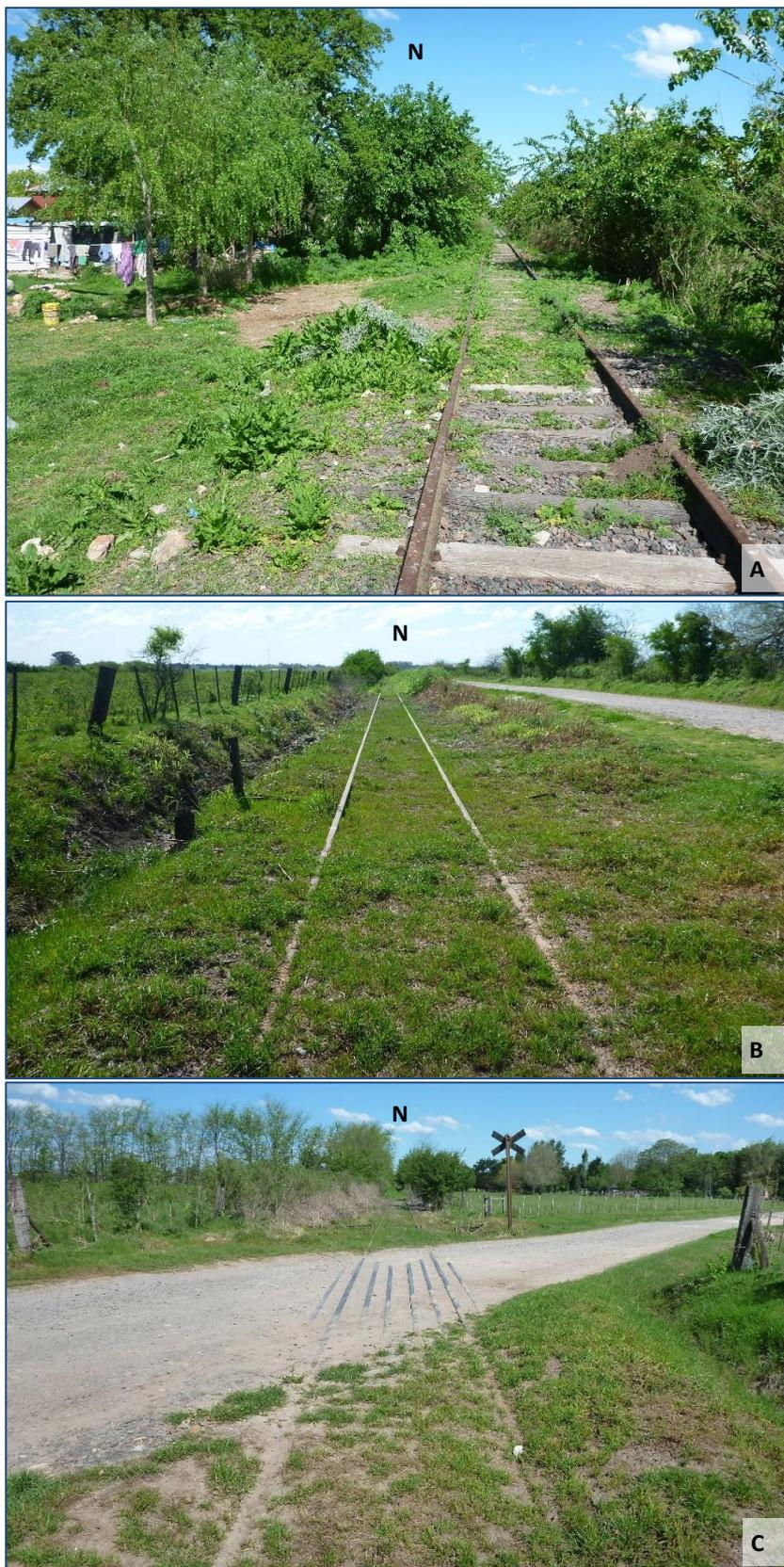
**Fotografía 16.24** Continuación de la traza de la vía actual del FCGU por la localidad de Parada Orlando en dirección a Capilla del Señor. La traza será retrochada a doble vía trocha mixta.
