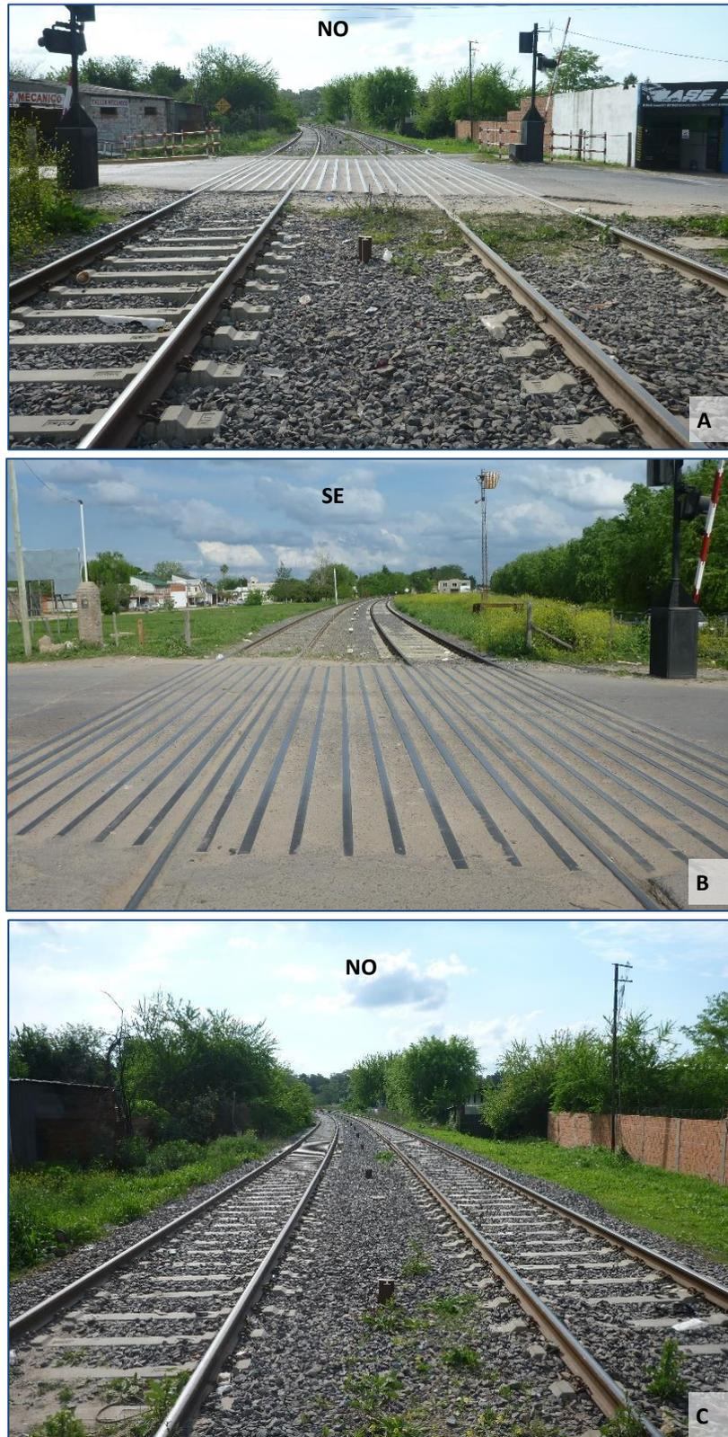
**Fotografía 16.47** Vía doble trocha ancha del FCBM en el PAN España en sentido noroeste, hacia el Puerto de Contenedores de Murchison (foto A) y en sentido sureste (foto B). Continuación de la traza en sentido noroeste. Se observa la doble vía trocha ancha del FCBM que llega hasta el Puerto de contenedores. Se hará un retrochado de la misma pasando a ser trocha mixta.
