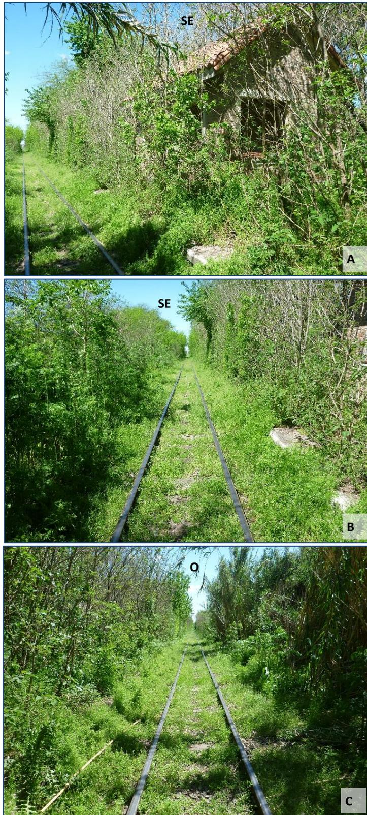
**Fotografía 16.18** Estación Lemée del Ferrocarril General Belgrano (FCGB). Se observa la vía simple trocha angosta del mismo. En cercanías a esta estación se llevará a cabo el empalme del FCGU y del FCGB. Se enlazará la vía simple trocha angosta del FCGB con la nueva doble vía trocha mixta del
