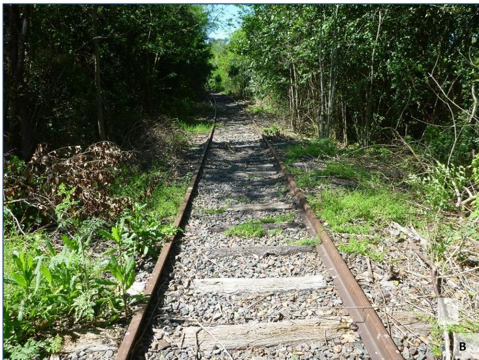
**Fotografía 16.9** Continuación de la vía actual del FCGU luego del cruce por los puentes sobre el río Luján en sentido oeste. Se observa en la foto B un parche de ligustros a los costados de la vía junto a vegetación frondosa. Esta traza será retrochada a doble vía trocha ancha.
