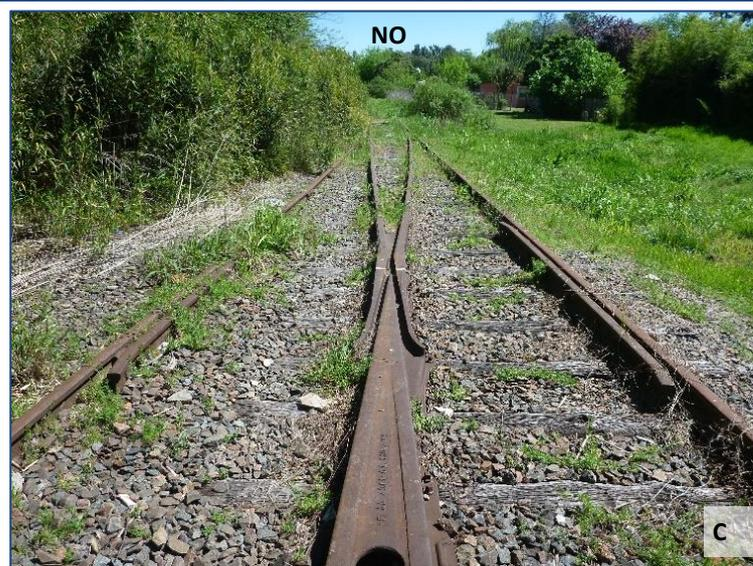
**Fotografía 16.13** Se observa el PAN Quimo Costa en dirección hacia Zarate (foto A) y hacia Buenos Aires (foto B). En la imagen C, vista hacia el noroeste, donde se aprecia la unión de ambas vías continuando una sola (vía simple trocha media del FCGU).
