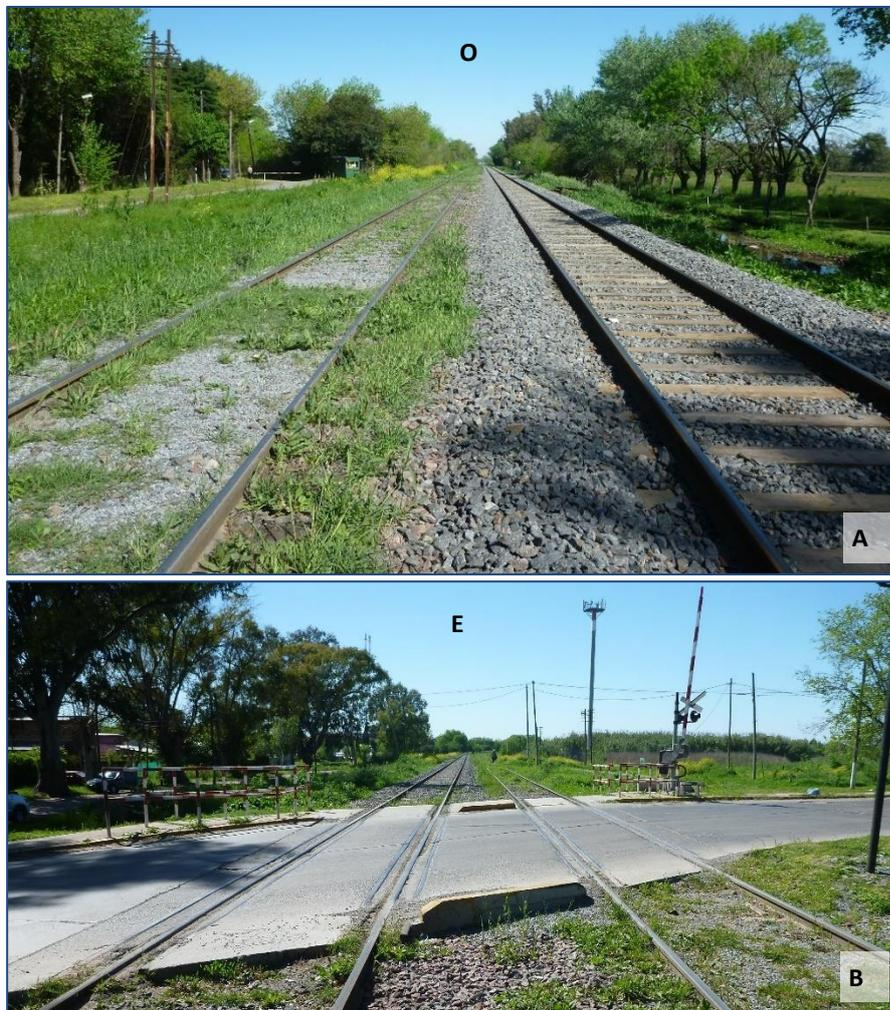
**Fotografía 16.1** Vistas desde el PAN Mercedes en dirección oeste, hacia Zarate (imagen A) y en dirección este, hacia Buenos Aires (imagen B) donde se observa la doble vía trocha ancha del Ferrocarril General San Martín (FCGSM).
