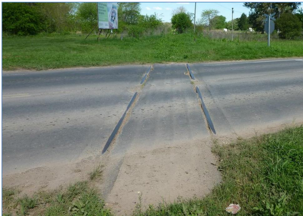
**Fotografía 8.7** Ejemplo Paso a Nivel de vía simple con una ruta asfaltada.
