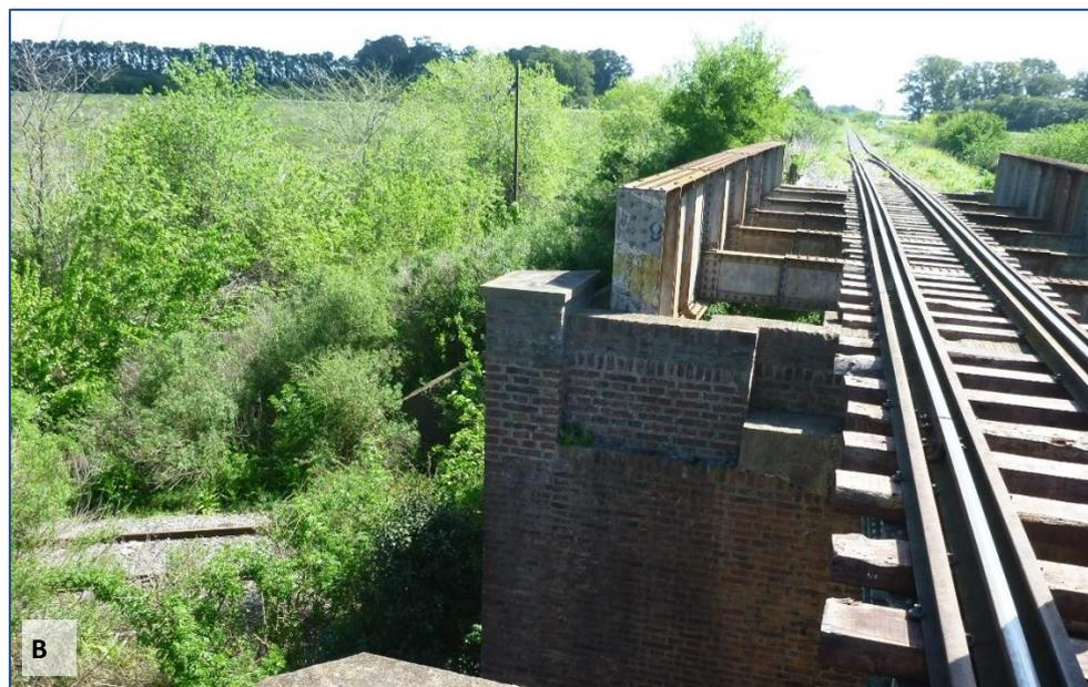
**Fotografía 16.21** Terraplén elevado. Por arriba del mismo pasa la vía simple trocha angosta del FCGB y por debajo la vía simple trocha media del FCGU (foto B).
