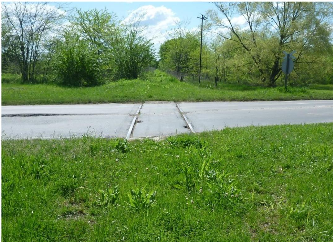
**Fotografía 8.14** Vía y balasto cubiertos de tierra y vegetación.
