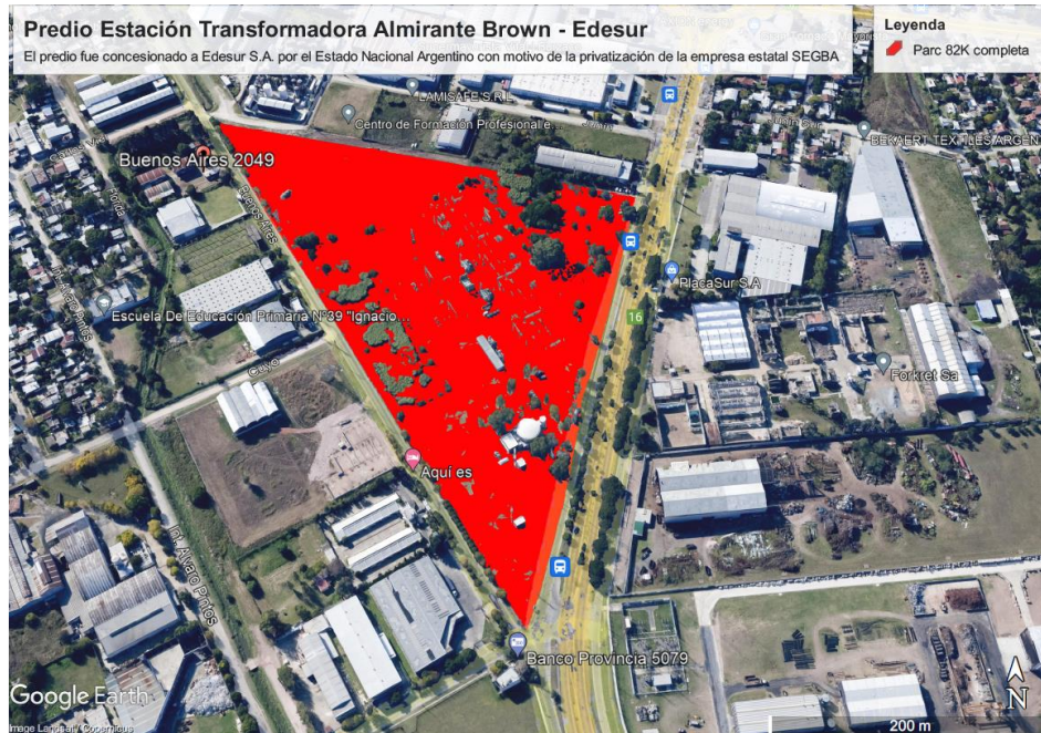
FIGURA 1: Vista del predio completo concesionado a la empresa EDESUR, dentro del cual se emplaza la Central Térmica Almirante Brown (imagen del archivo .zml adjunto)
