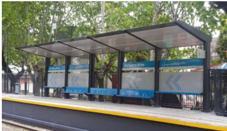
Figura 5 Imagen de referencia de las cubiertas
