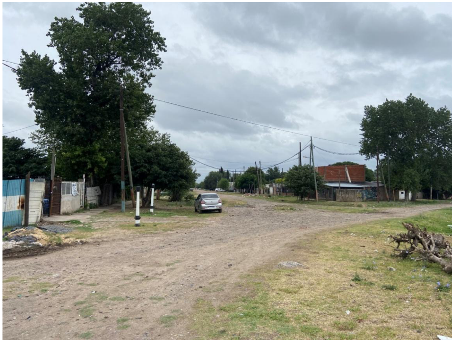
Fotografía 20 Vista suroeste en PR 6. Vista hacia la intersección de las calles Diagonal Los Tilos (margen sur) y Los Paraísos.
