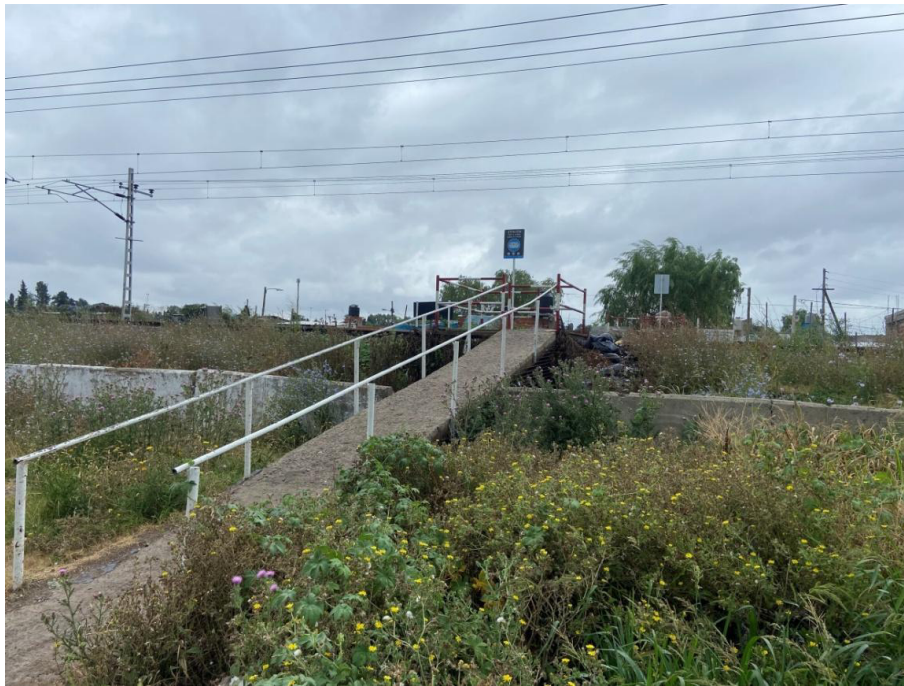
Fotografía 7 Vista al norte en PR 2. Vista desde Diagonal Los Tilos (margen sur) hacia las vías.
