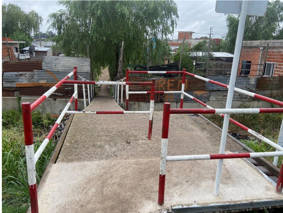
Fotografía 9 Vista al noreste en PR 2. Vista desde traza ferroviaria hacia viviendas encimadas al terraplén de las vías.
