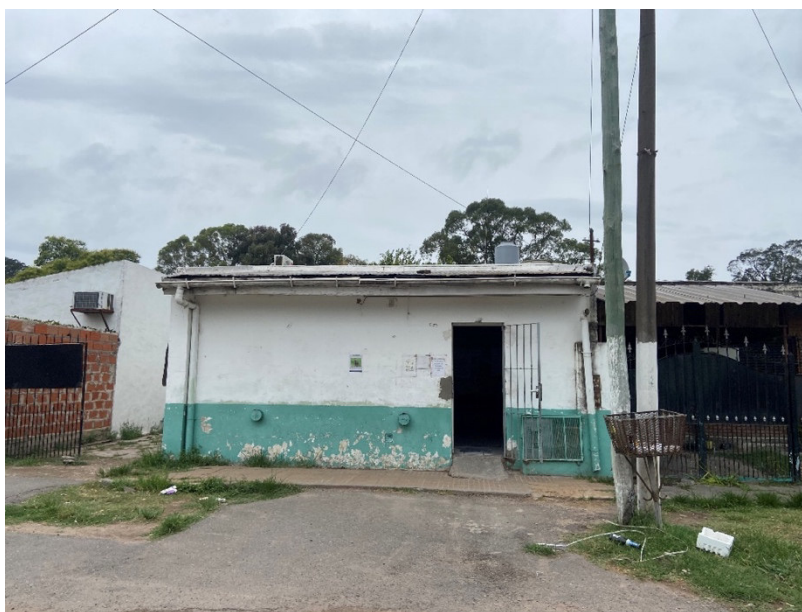
Fotografía 54 Vista del Centro de Salud Las Malvinas en el Barrio Las Malvinas, localidad de Gobernador Costa, Distrito de Florencio Varela
