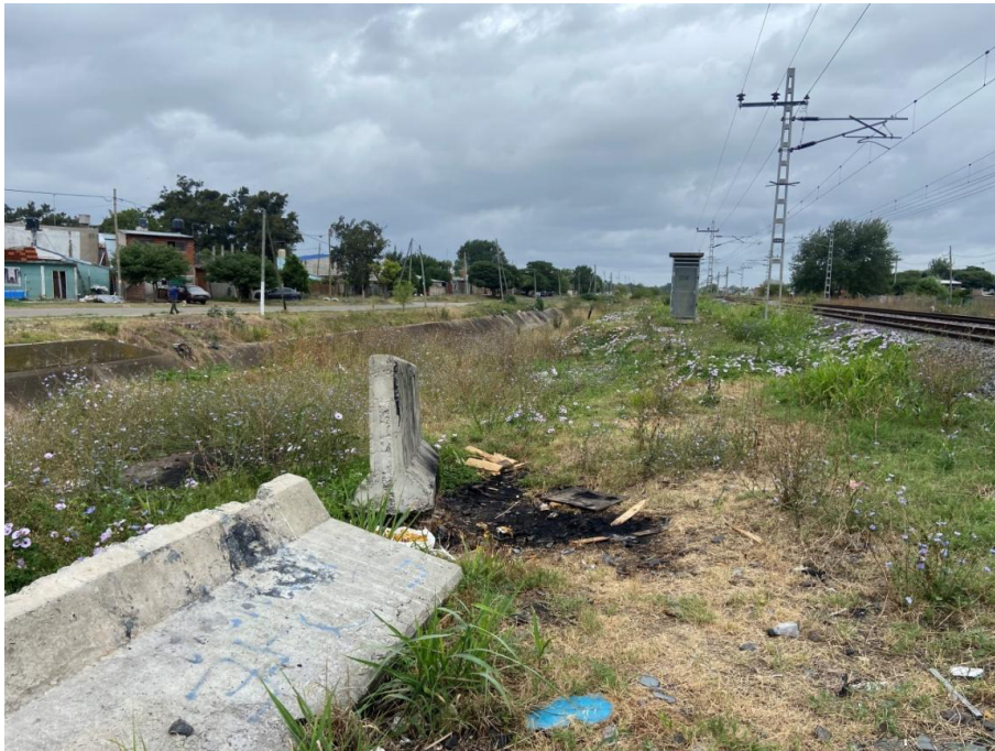
Fotografía 29 Vista al este PR 6. Vistas sobre el terraplén de las vías en su margen norte.
