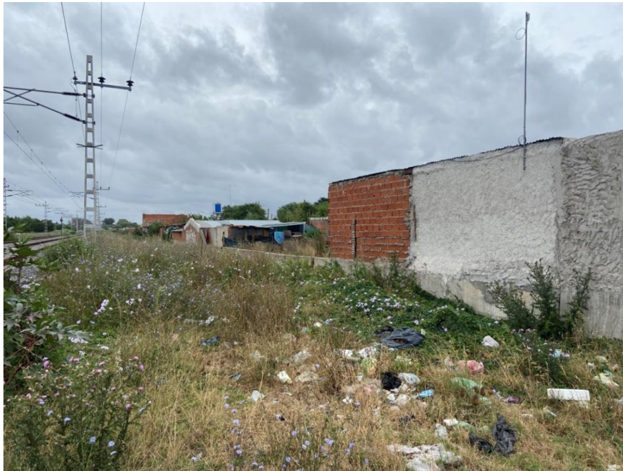
Fotografía 22 Vista oeste en PR 6. Vista del terraplén entre vías del tren y viviendas construidas sobre el muro de contención.
