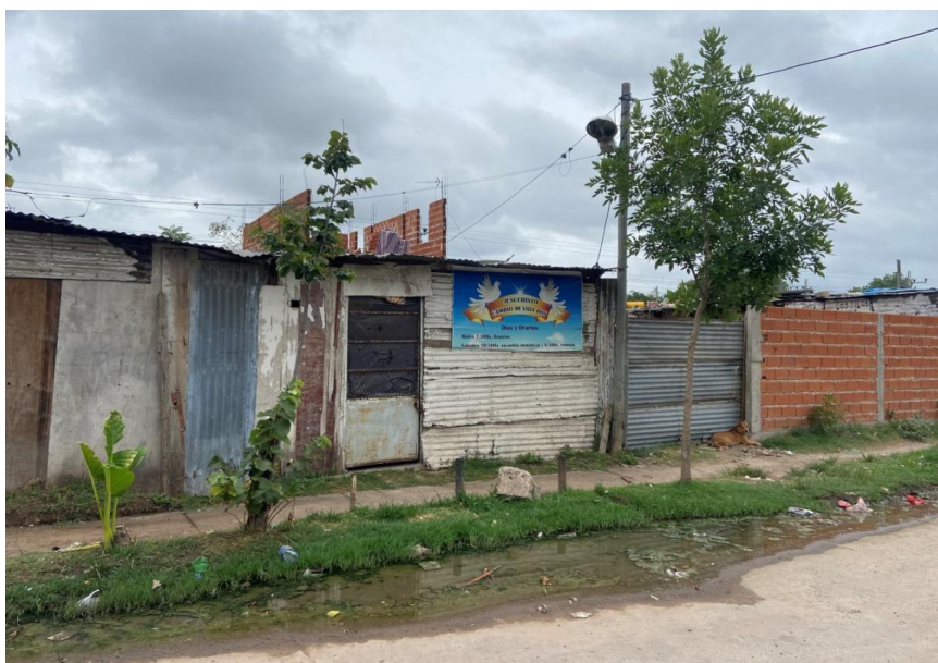
Fotografía 17 Vista Sur en PR 4. Vista hacia vivienda sobre Diagonal Los Tilos (margen norte).
