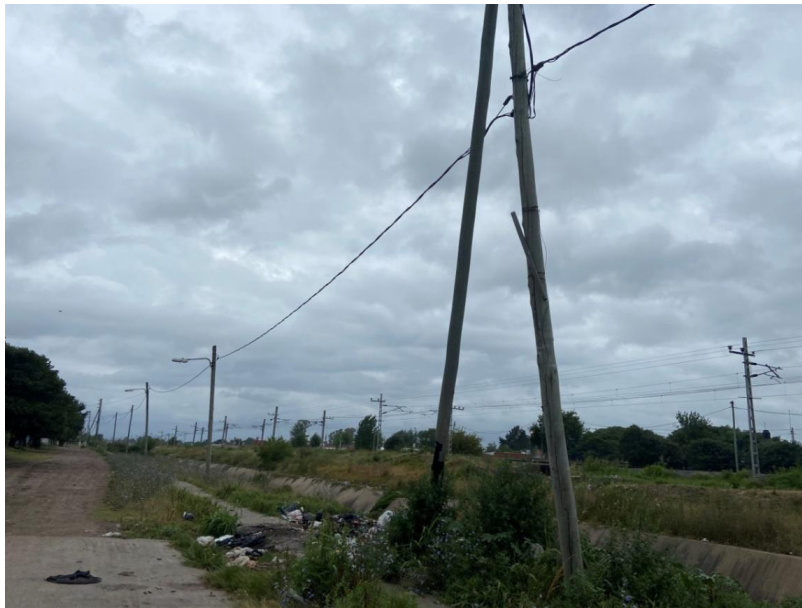
Fotografía 31 Vista al sureste en PR 7. Vista sobre la calle Diagonal Los Tilos (margen norte)
