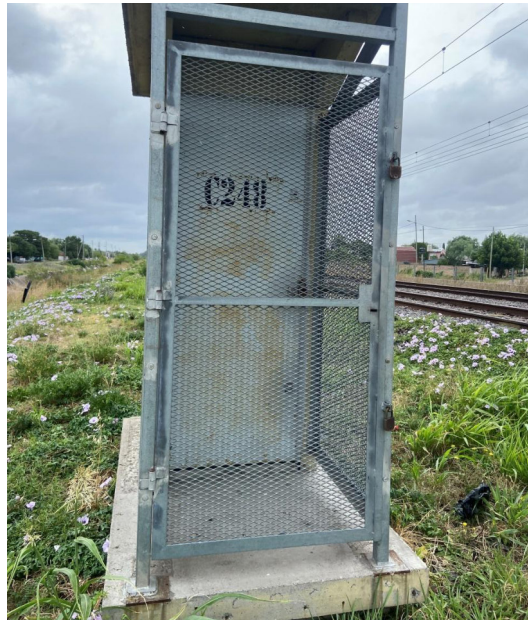
Fotografía 30 Vista al este en PR 6. Vista sobre el terraplén margen norte se observa una caseta, parte de la infraestructura asociada al funcionamiento ferroviario.
