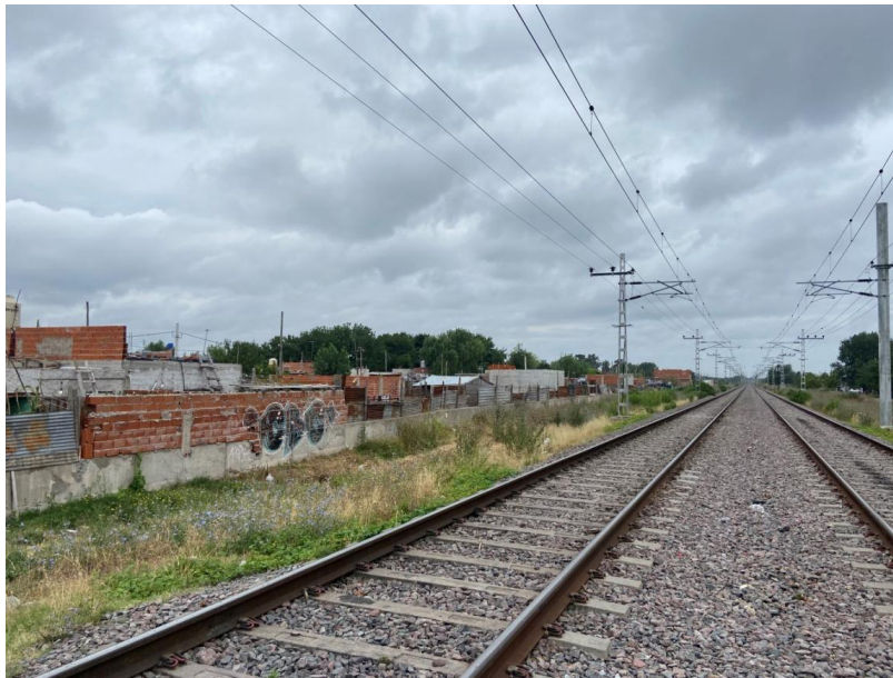
Fotografía 15 Vista al noreste en PR 3. Vista sobre la vías del tren hacia la Estación Ing. Ardigó.
