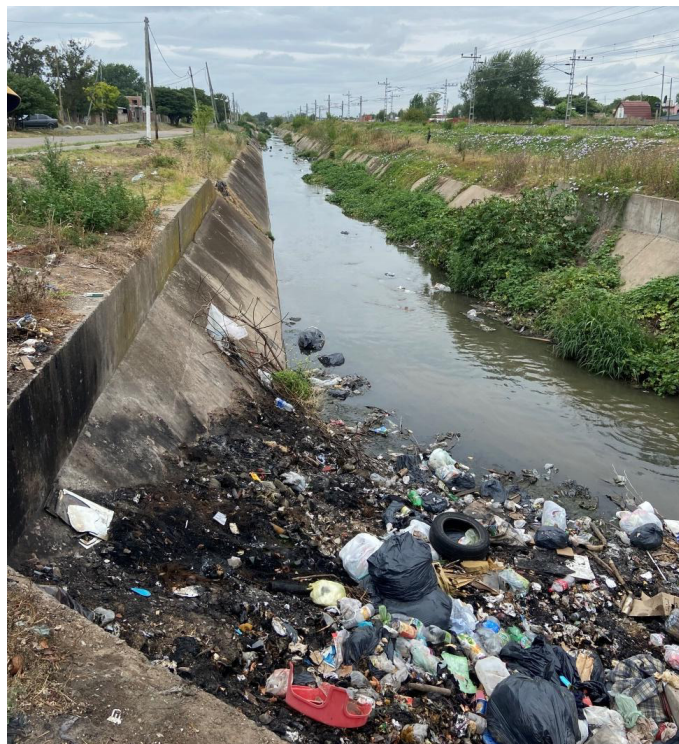
Fotografía 28 Vista al este en PR 6. Vista del canal desde camino del cruce informal de vías.
