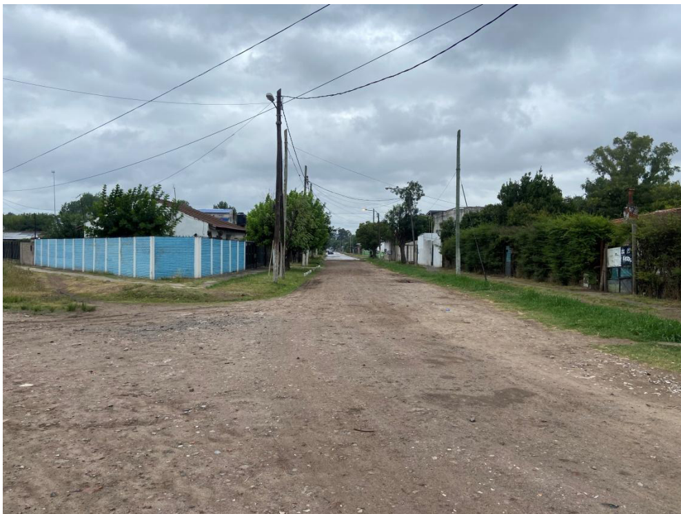
Fotografía 2 Vista al sureste en PR 1. Vista desde la intersección de las calles Diagonal Los Tilos (margen sur) y El Zorzal.
