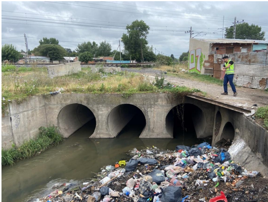
Fotografía 26 Vista sur en PR 6. Vista desde Diagonal Los Tilos (margen norte) hacia cruce peatonal informal de vías.
