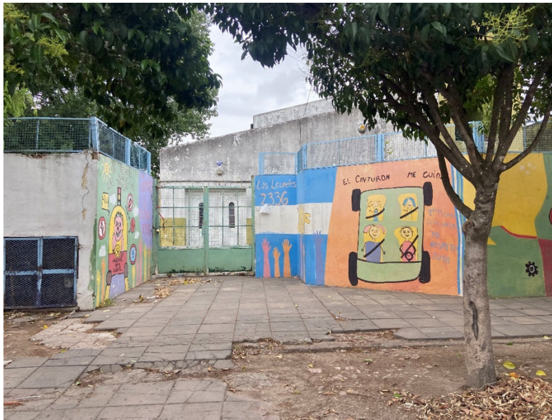
Fotografía 51 Vista de entrada principal del Jardín de Infantes N°915 en el Barrio Las Malvinas, localidad de Gobernador Costa, Distrito de Florencio Varela
