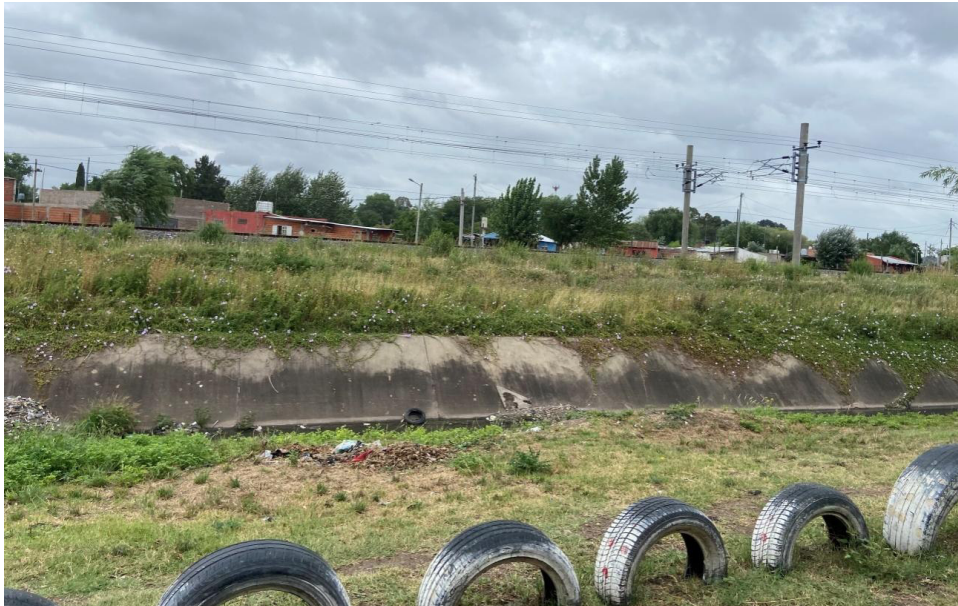
Fotografía 42 Vista sur en PR 10. Vista desde calle Diagonal Los Tilos (margen norte) hacia canal y terraplén de las vías.
