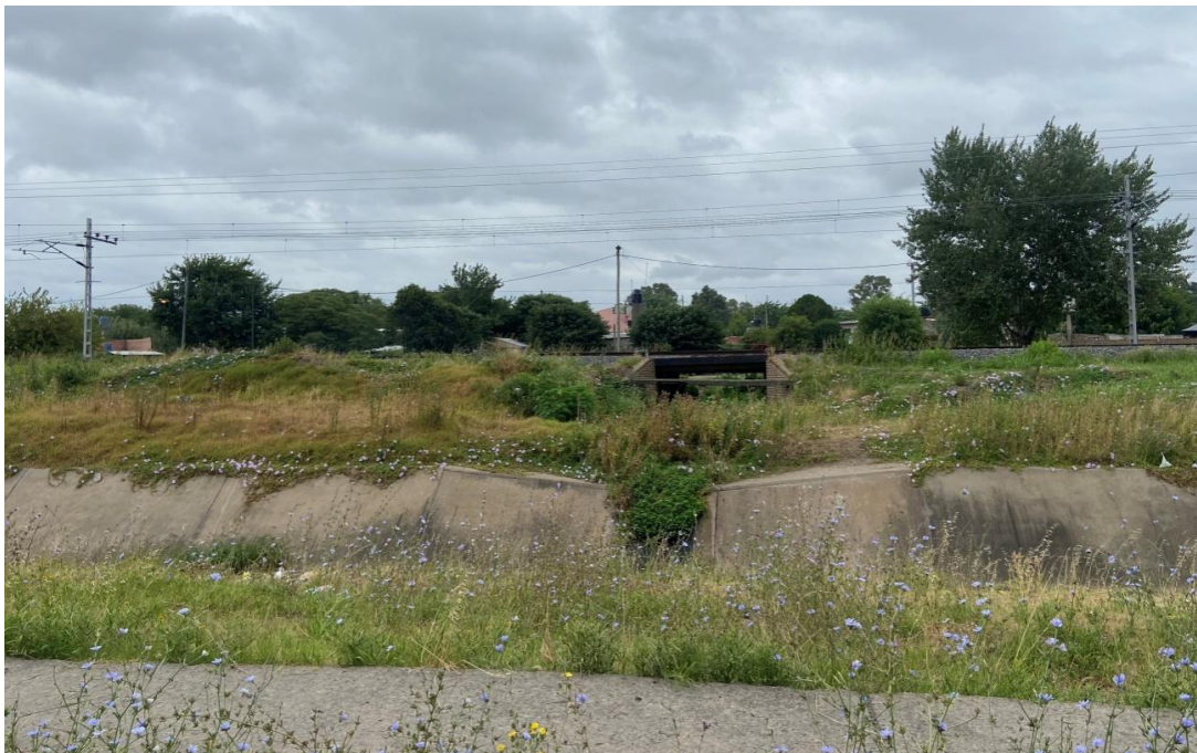
Fotografía 35 Vista al sur PR 8. Vista desde el canal hacia el terraplén de las vías, con conexión al cauce superficial y alcantarilla.
