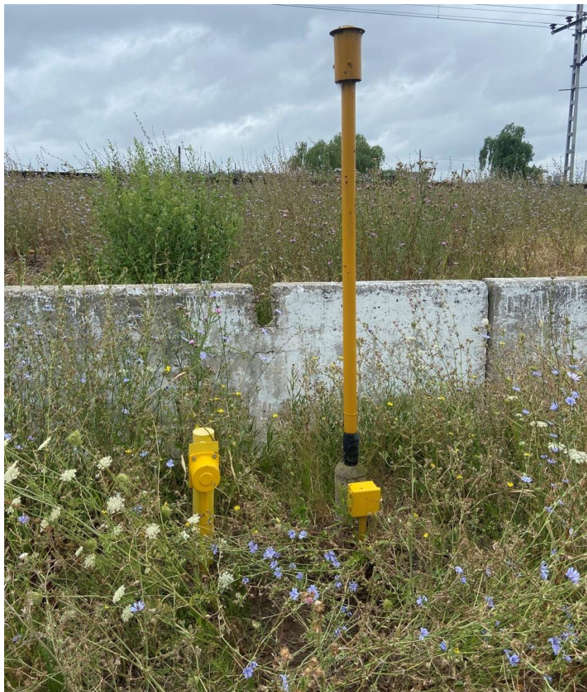
Fotografía 5 Vista al norte en PR 2. Vista desde Diagonal Los Tilos (margen sur) hacia las vías.
