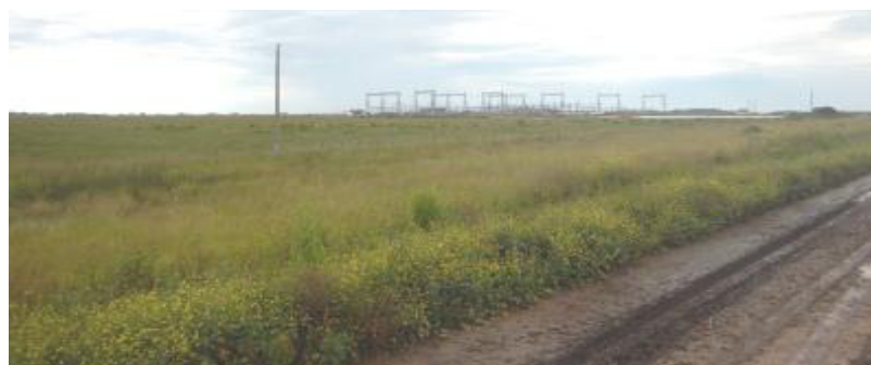
Vista del ingreso de la Alterativa A, a la ET Vivoratá.
