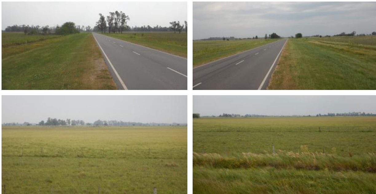
Punto de cruce de la Alternativa B y acceso a la localidad de Plomer. Vista a los cuatro puntos cardinales.
