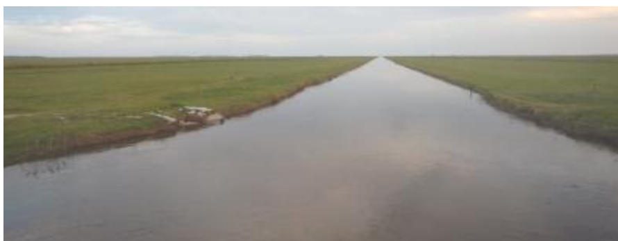
Vista Este (hacia donde trascurriría la Alternativa B) del Canal 9.
