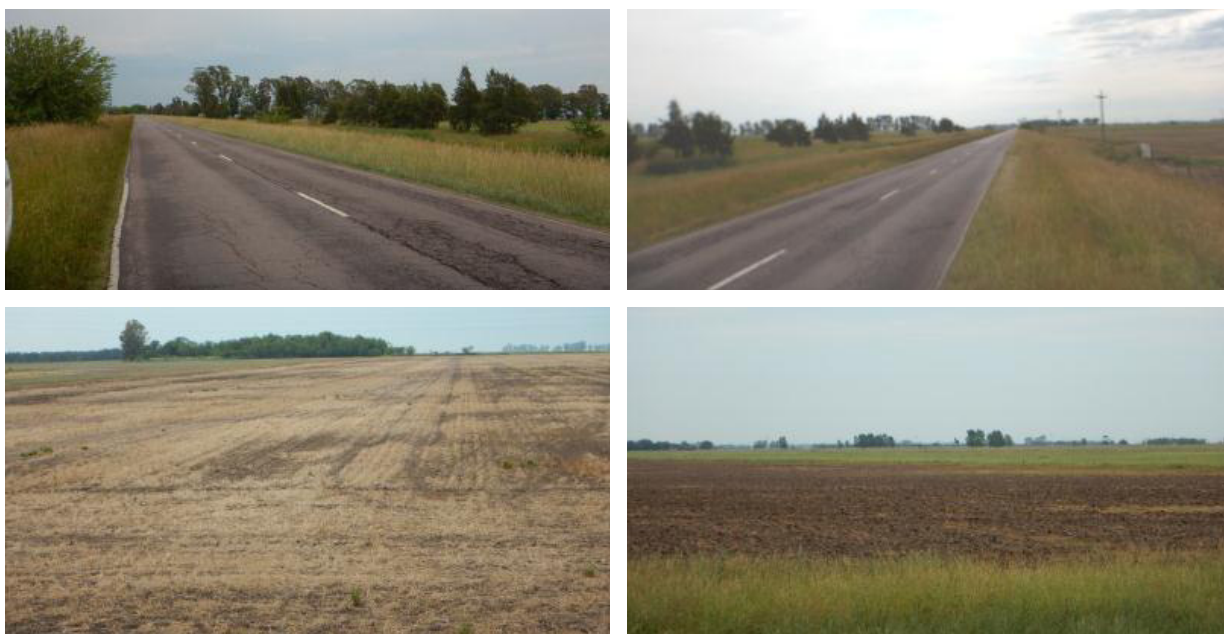
Punto de cruce de la Alternativa A y con la Ruta Provincial N° 215. Vista a los cuatro puntos cardinales.
