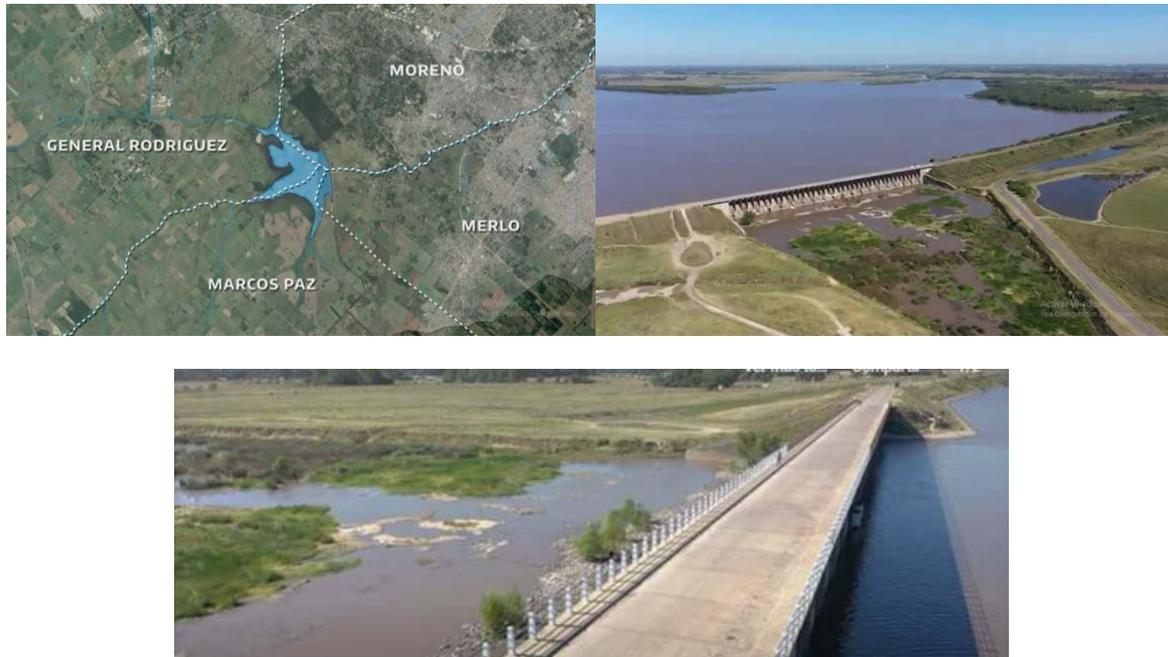
**Figura 2. Ubicación y vista general de la Presa Ingeniero Roggero y Lago San Francisco. Detalle del coronamiento de la presa con calzada de pavimento**
