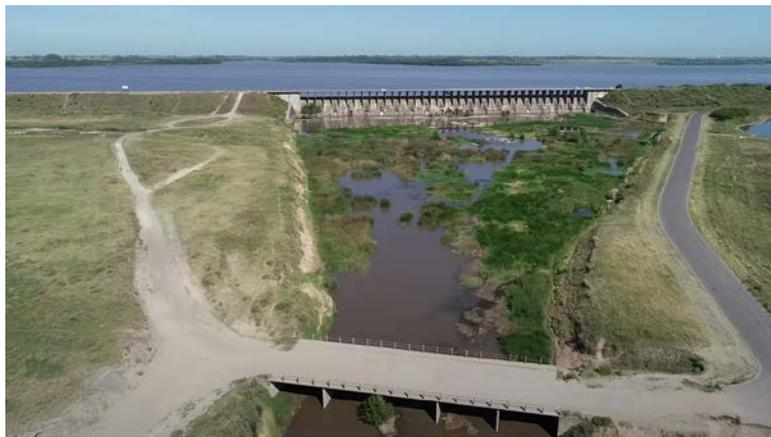
**Figura 9. Sección de restitución al cauce y puente vial y peatonal. Fuente: DPH**
