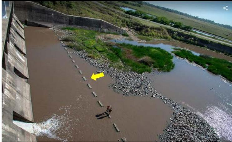
**Figura 8. Vista general del dissipador de energía. Tope de dientes alternados y material de arrastre en el inicio de la sección de restitución al cauce. Fuente: DPH.**
