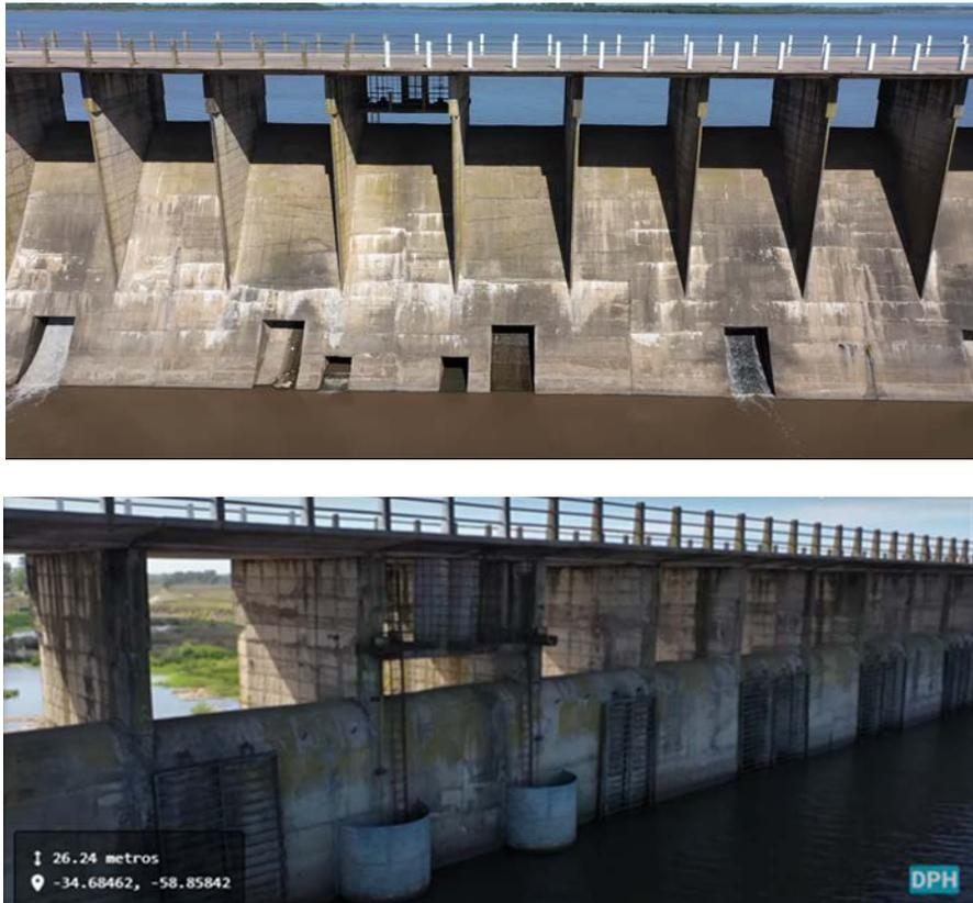
**Figura 7. Vista de Vista desde aguas abajo y desde aguas arriba, de las dos compuertas rectangulares con sistema de izaje manual que sirven como descargadores de fondo**
