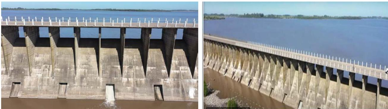
**Figura 3. Detalle desde aguas abajo de la Presa Ing. Roggero. Se observa el módulo de la cresta del vertedero, orificios y cuenco disipador**
