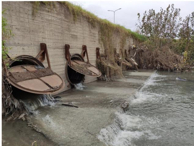
**Figura 19. Vista del funcionamiento de las compuertas capleta circulares**
