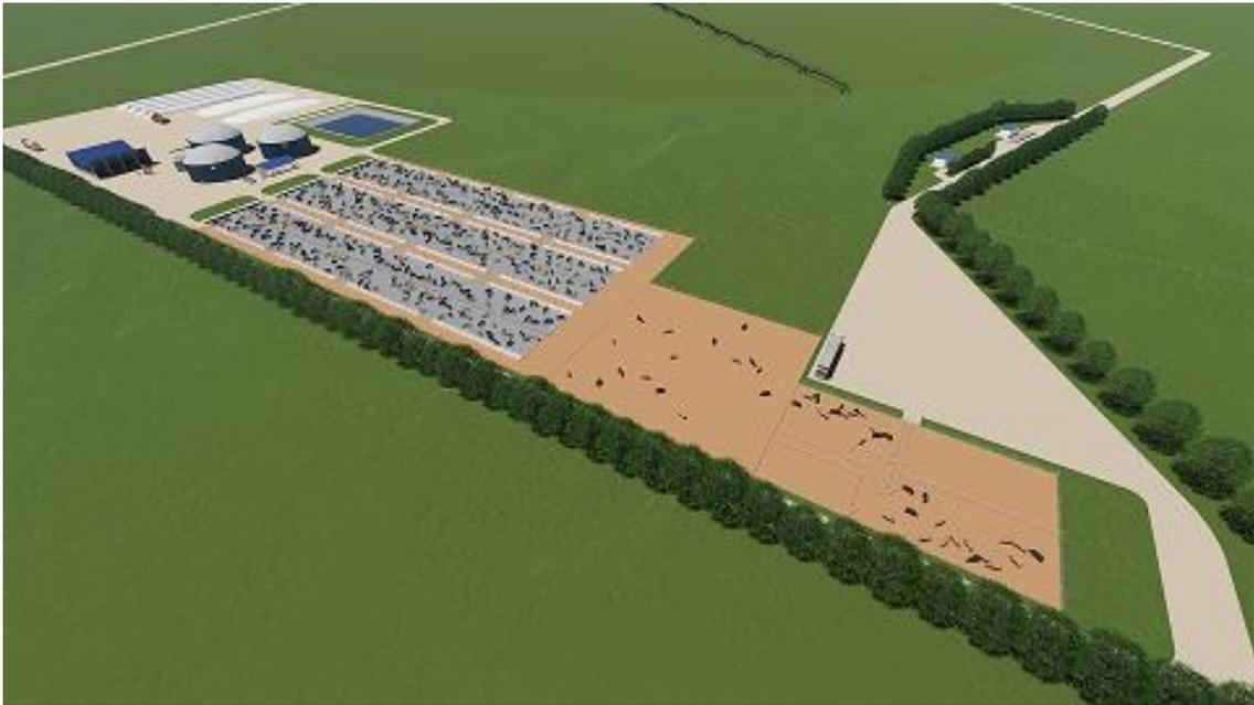
La infraestructura requerida está conformada por los **corrales de hormigón**, las **cámara de cargas**, los 2 **reactores primarios** y el **post-digestor** (los 3 reactores tienen igual tamaño); y por último la **pileta de descarga**, donde se almacenará el biofertilizante líquido (Biol).
