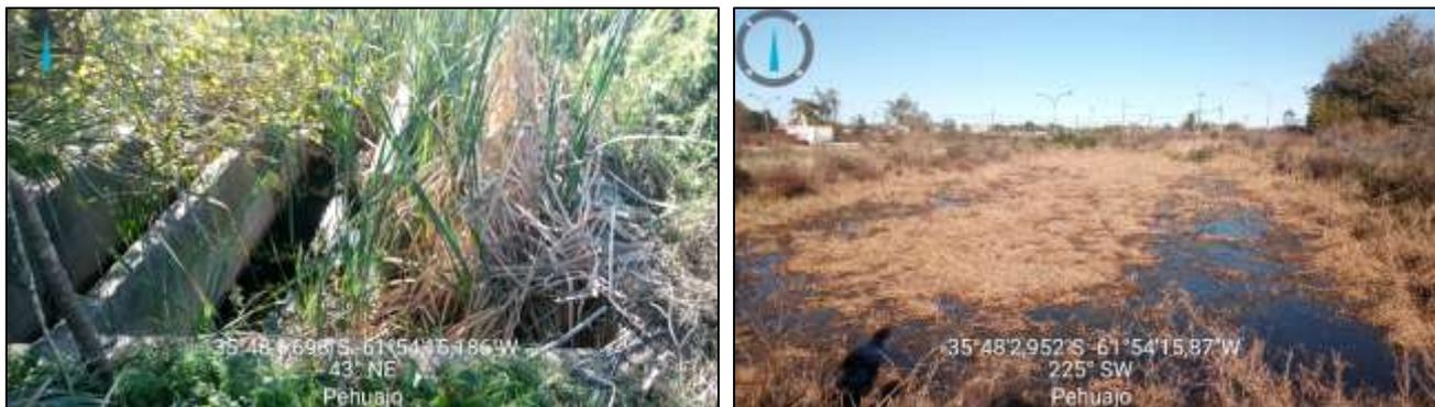
Figura 48 – Vista cámara de contacto no conectada al sistema de tratamiento (izq) & laguna abandonada (der)
