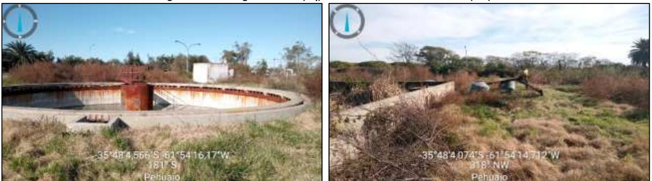
Figura 47 – Vista Imhoff (izq) & equipamiento abandonado (der)
