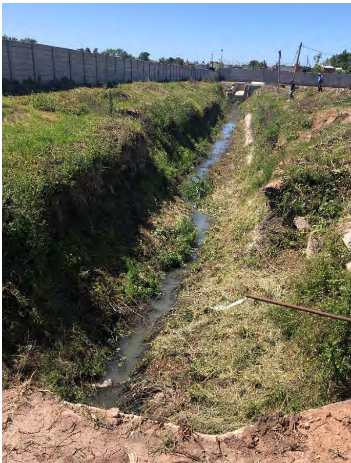
Canal de descarga del reservorio
