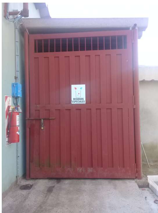
Figura 7: Depósito de residuos especiales del Frigorífico Gorina
