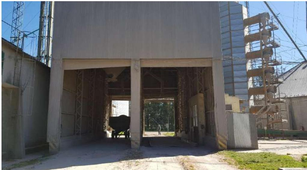
*Cabina de descarga de granos con cerramientos y equipamiento de aspiración.*
