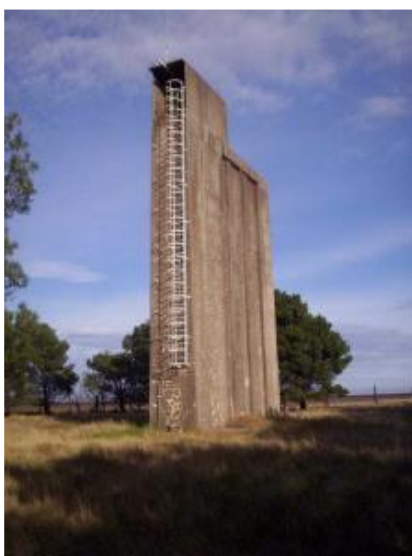
Figura 5: Acueducto Principal – Hormigón Pretensado
