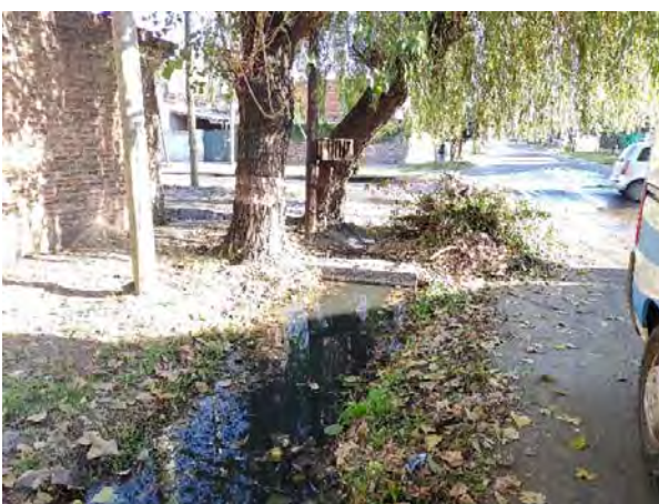
Figura 19: Gral. Conesa esquina Amberes. Zanja colmatada
