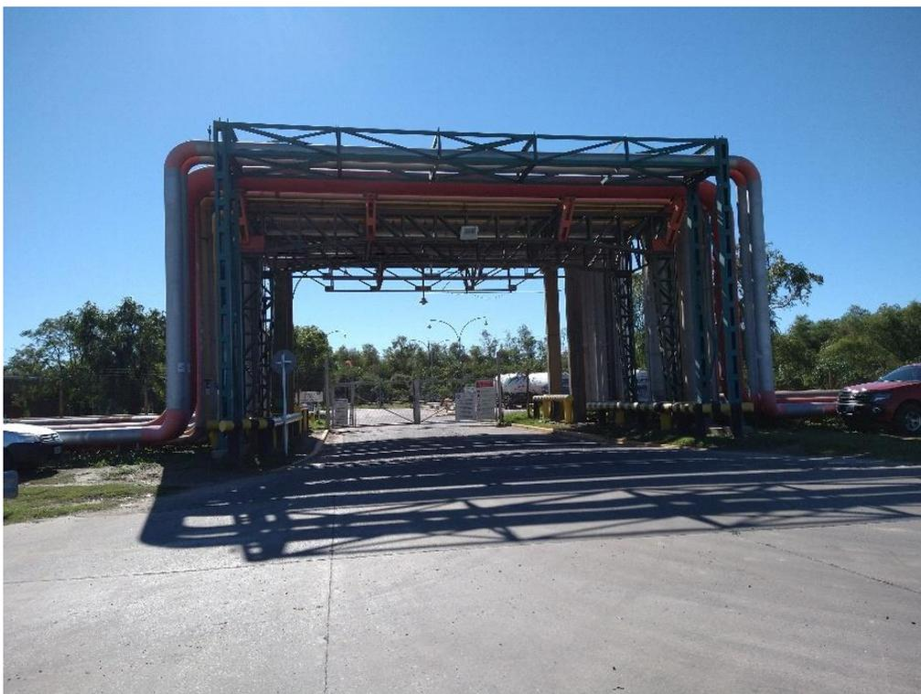
*Ilustración N° 16 – Tendidos existentes en altura*
