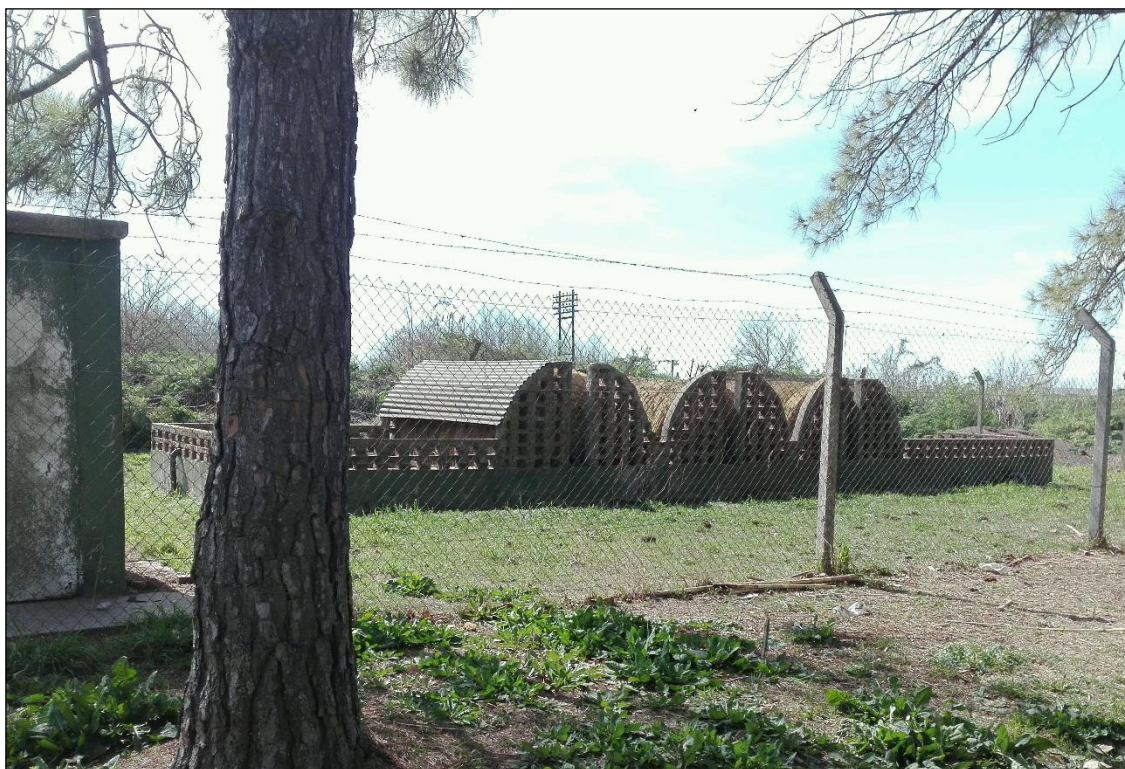
Figura 13: Vista planta compacta de biodiscos rotativos
