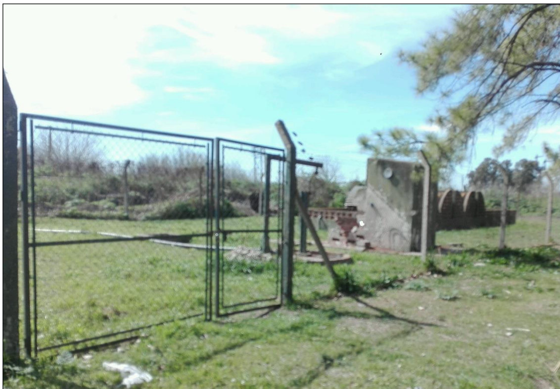
Figura 12: Vista PDLC, en primer plano pozo de bombeo y casilla de desinfección.
