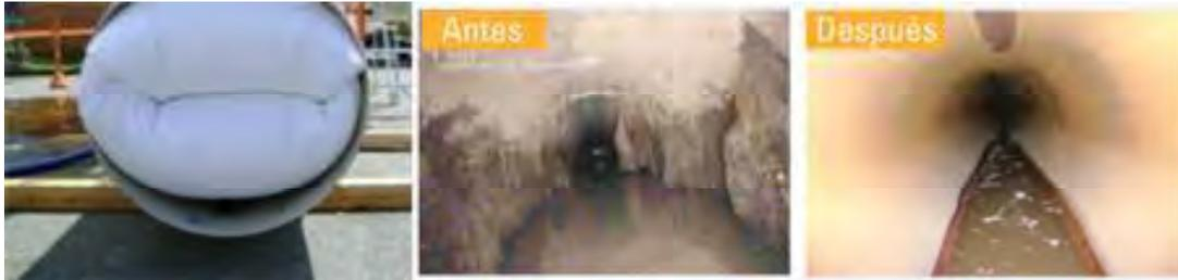
Figura 78: Rehabilitación de cañería por método CIPP
