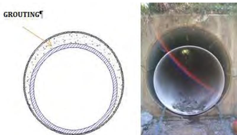
Figura 79: "Caño portador"- *carrier pipe*, instalado en "caño receptor"-*host pipe*, relleno-*grouting* del espacio anular entre los dos tubos
