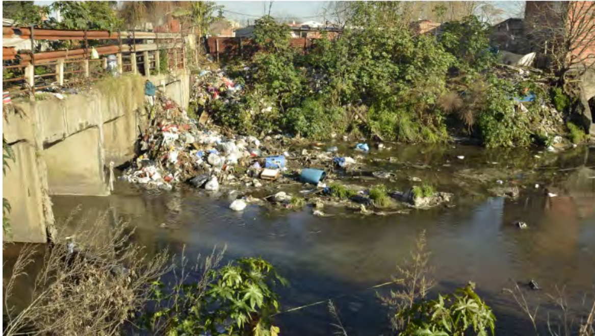
Figura 8: Desembocadura del entubamiento del arroyo Morón 27 .
