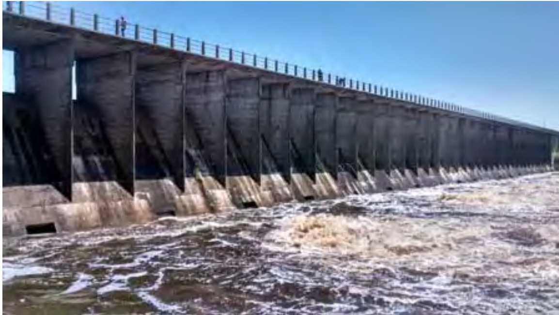
Figura 6: Presa Ingeniero Carlos Roggero. 21
