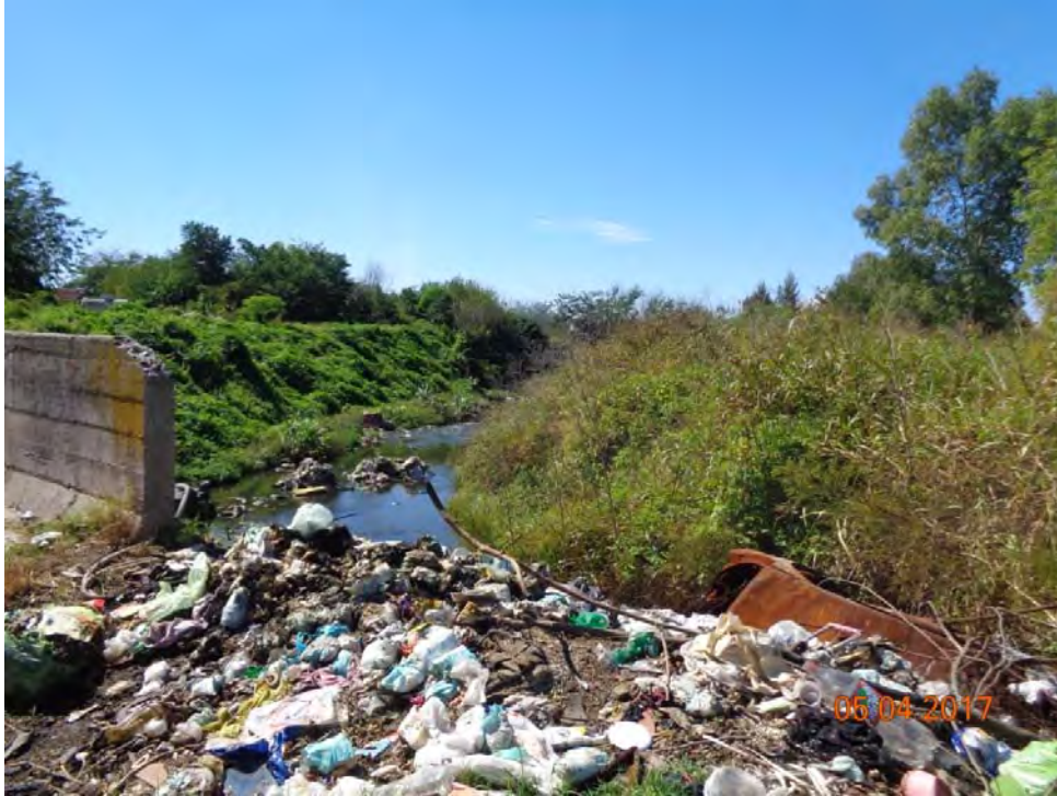
Figura 9: Cruce del Arroyo Las Catonas.
