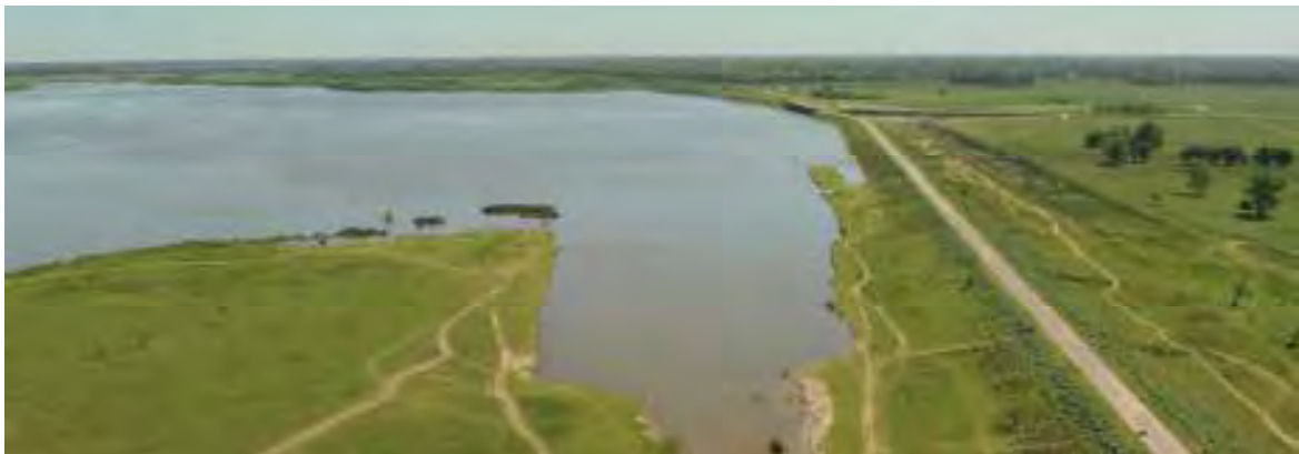
Figura 1. Aguas endicadas para control de inundaciones (Lago San Francisco), compartido por los partidos de General Rodríguez, Moreno, Merlo y Marcos Paz. Pasando el terraplén (Dique-Represa Ing. Roggero), se origina el Río Reconquista. El paisaje es rural, con un sector boscoso al fondo (Parque Los Robles).
