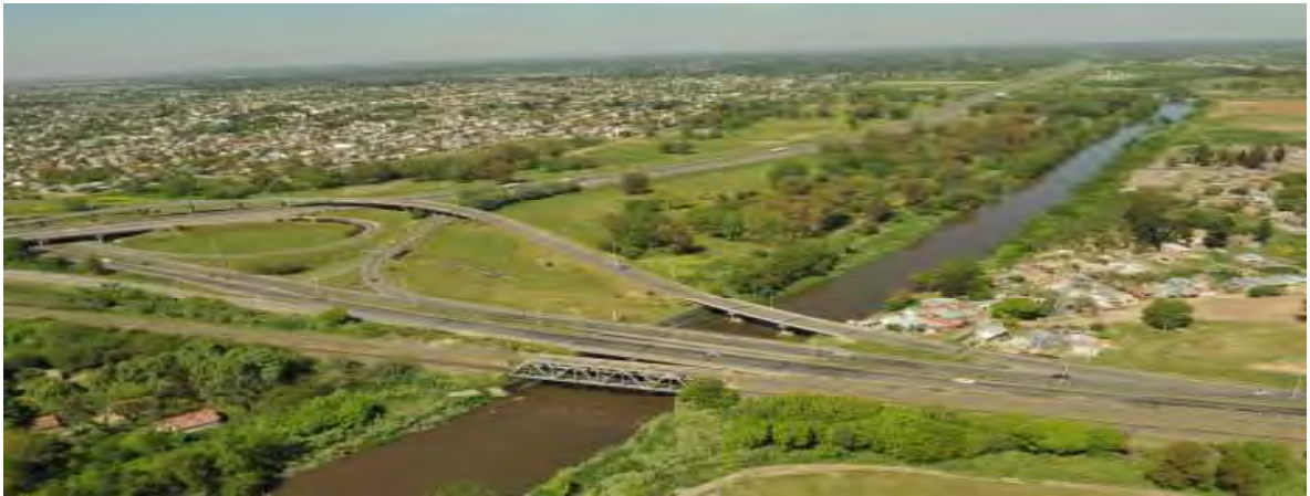
Figura 4. Cruce de la Ruta Provincial 201 sobre el río Reconquista (RCQ-R201) (vista aérea).
