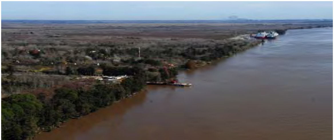
Figura 12. Vista aérea del río Paraná de las Palmas con la Torre de Toma de aguacrua en construcción (PP-TT). Aguas arriba y abajo ( \pm 100/200 m), se localizan las estaciones de muestreo PP-arTT y PP-abTT. Al fondo se observa el puerto de la planta regasificadora YPF (julio 2015).
