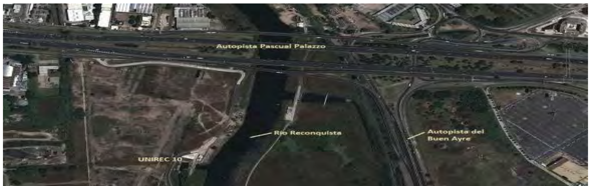
Figura 5. La Estación de Bombeo 10 UNIREC/COMIREC, se observa a la izquierda de la imagen (RCQ-EB10).
