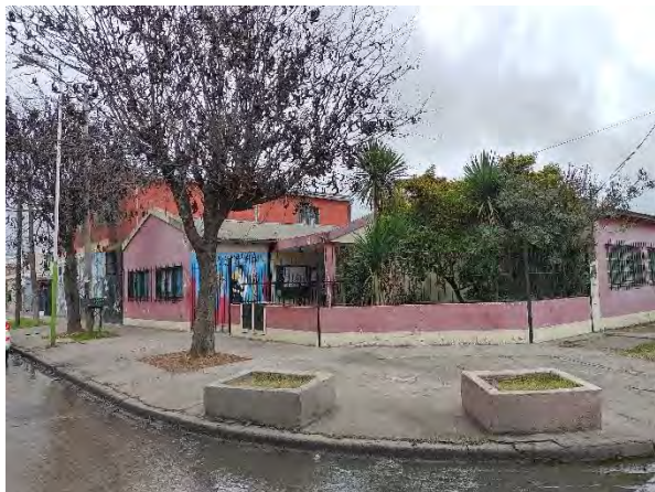
Figura 01: Luis Vernet esquina Paso de Uspallata. Escuela N° 38 Juan Manuel de Rosas / Escuela Secundaria Básica N° 35
