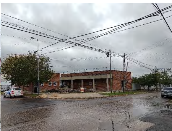
Figura 02: Luis Vernet esquina Batalla de Chacabuco. Unidad Funcional Grand Bourg Sur. Centro de Atención Primaria de la Salud
