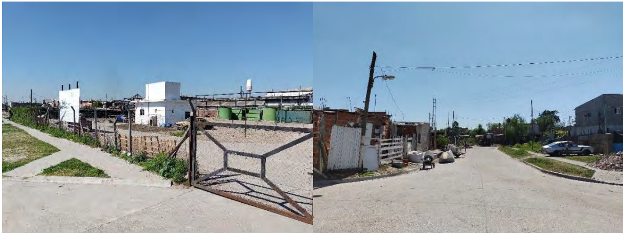
Fotografía 13: Predio de la futura Estación de Bombeo Cloacal
