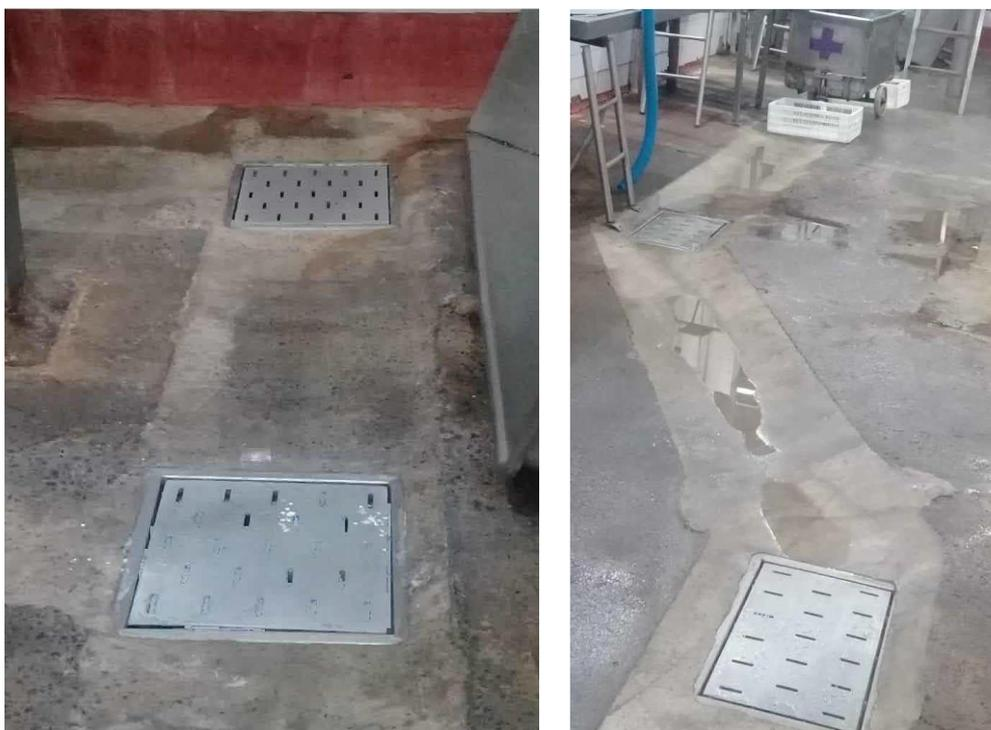
*Imagen. Vista de canaletas y rejillas colectoras de sangre.*
