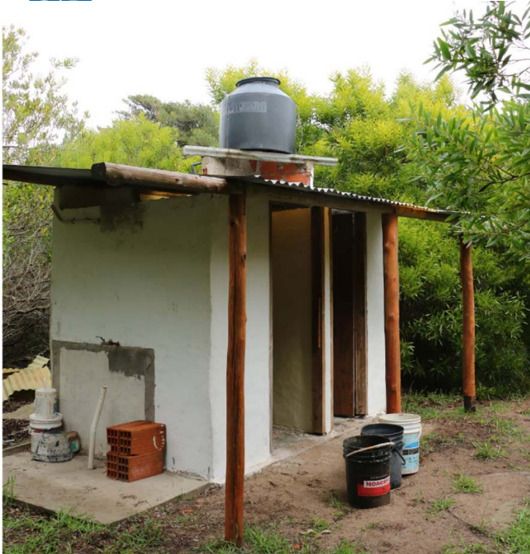
Núcleo sanitario a demoler
