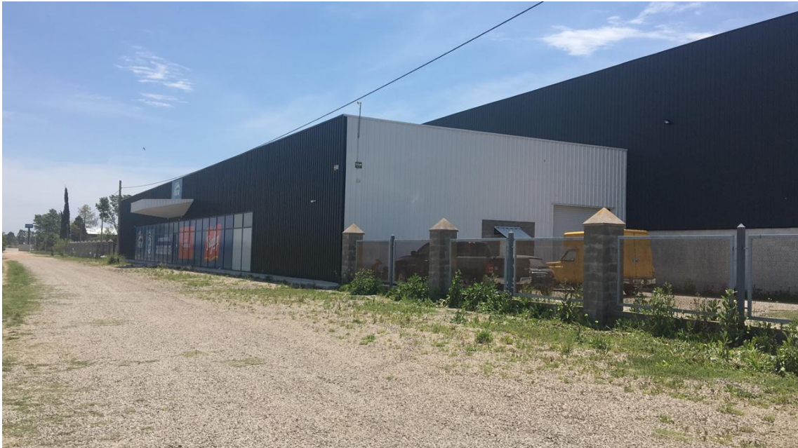
Imagen N° 30: Distribuidora sobre la calle colectora.
