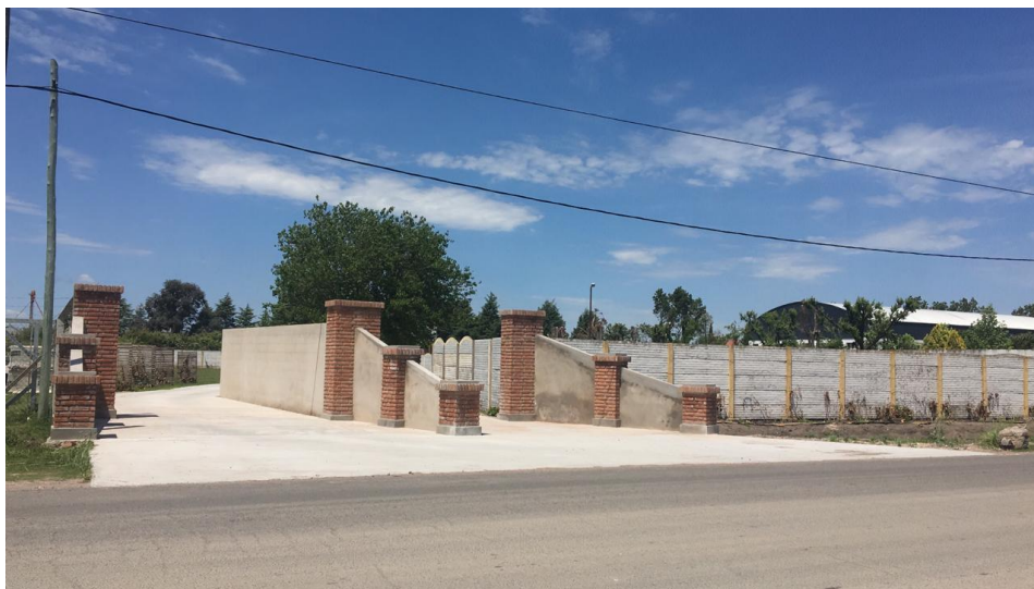
Imagen N° 23: Salida del motel, sobre calle Pellegrini.
