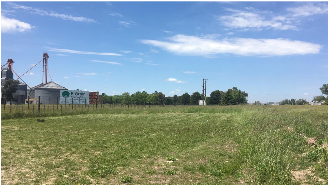
Imagen N° 46: Vista del final de la colector. Es decir, lo que falta construir.
